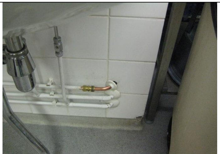
Kuva 12. keittiö Vuotokohdan uusittu putki.
