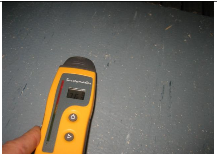
Kuva 4. Siivouhuone. Korkeita pintakosteuslukemia muovimaton alla.
