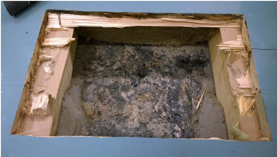
Kuva 5. Rakenneavaus 2 tehtiin luokan 108 lattian keskelle; Lattiassa on puurakenteinen pintakerros, jonka alapuolella olevan betonilaatan päällä on tervasiveily.
