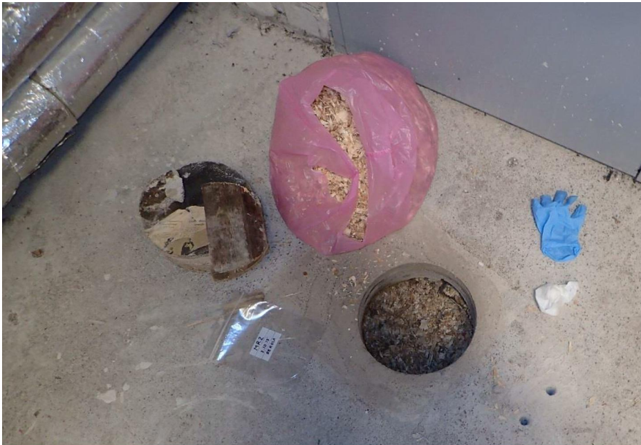
Kuva 10. Yläpohjan rakenneavaus ullakon lattiassa.
