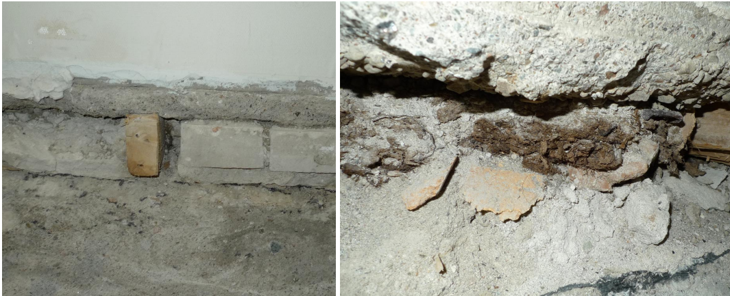
Kuva 3 ja 4. Rakenteissa on jäljellä rakennusaikaista puuainesta ja turvetta.
