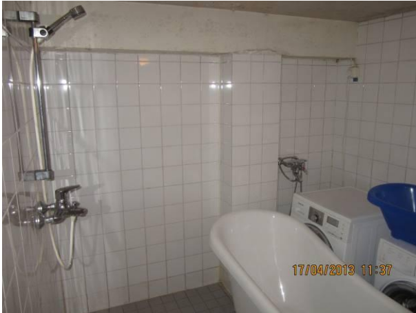
Kuva 25 Talosaunan pesuhuone, jossa on myös pyykinpesutilat..
