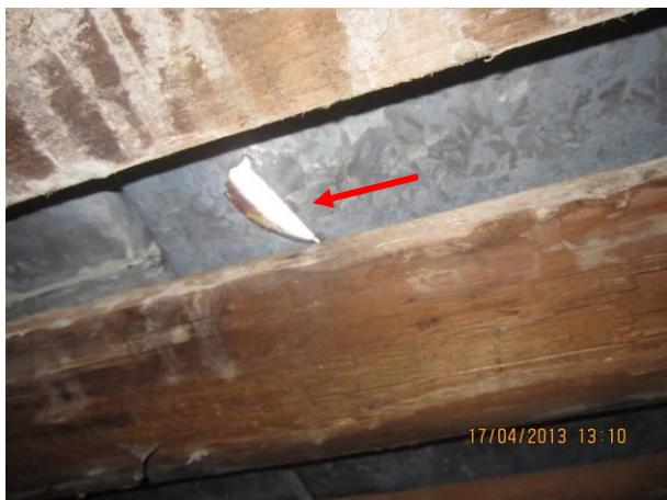
Kuva 21 Peltikatteen viiltoreikä.
