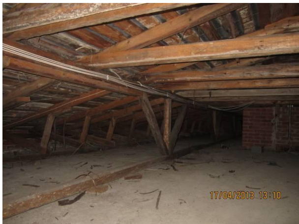
Kuva 19 Korkean osan yläpohjaontelo.
