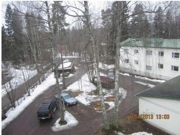
Kuva 1 Yleiskuva yläpihalta, muutama puu on poistettu keväällä 2013.
