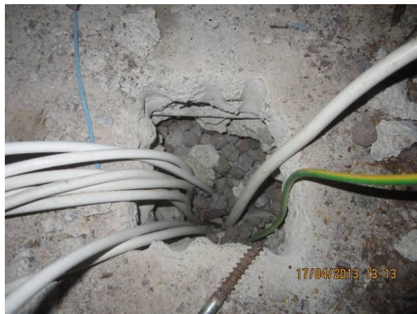
Kuva 20 Yläpohjan palopermannon alla on kevytsoraeristys.
