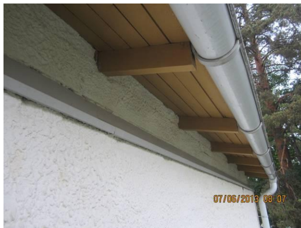
Kuva 22 Yleiskuva räystäältä, uusitut rännit.
