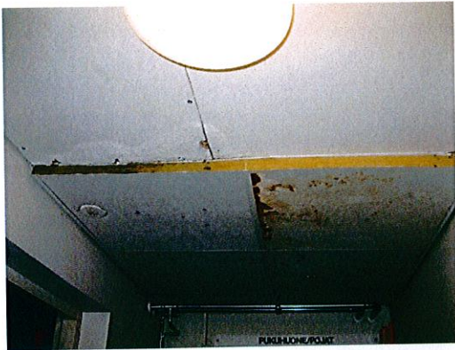
Kuva 1. Pukuhuoneiden yhdyskäytävän katto
