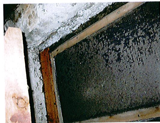
Kuva 4. Pääkoulun raitisilmäsäleikkö
