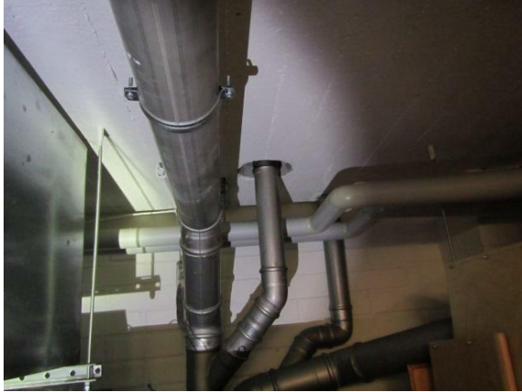
Kuva 28. Uusittuja keittiön viemäreitä (HST).
