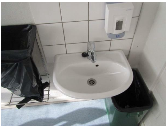
Kuva 22. Uusittu 1-otehana wc-tilassa.
