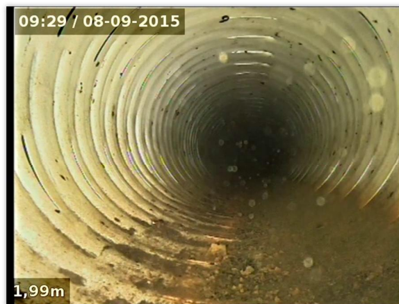
Kuva 5. Etupihan salaojaa täynnä vettä (TV8_SO).
