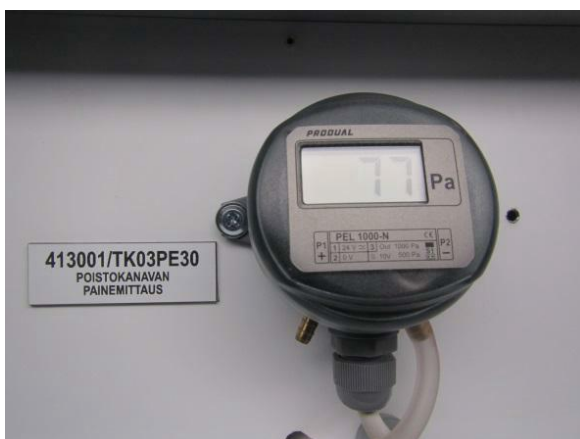
Kuva 53. Pro dualin painelähetin (TK03).
