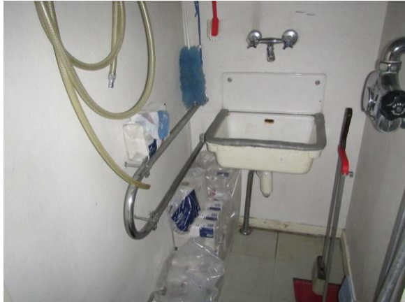
Kuva 12. Siivouskomeron käyttövesipatteri.
