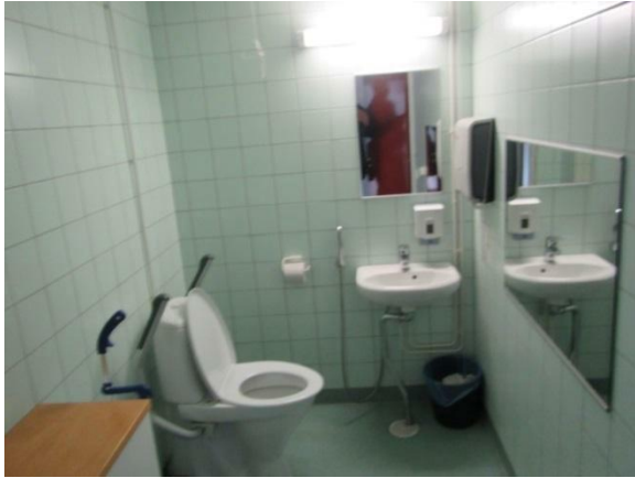
Kuva 24. Uusittuja kalusteita ja kytkentäjohtoja pinta-asennuksina.
