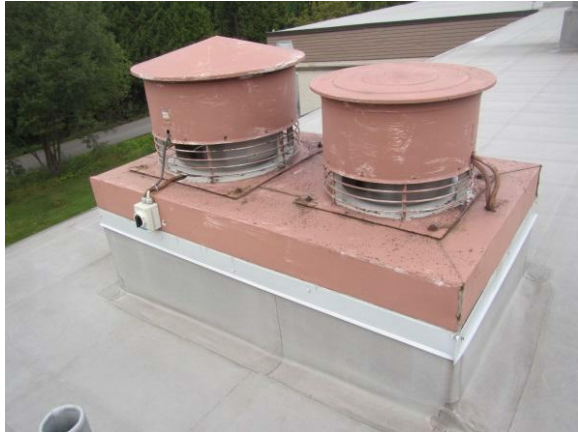
Kuva 42. Alkuperäisiä asennuksia 1960-luvulta.
