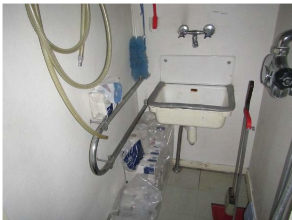
Kuva 23. Alkuperäinen 2-otehana siivouskomerossa.
