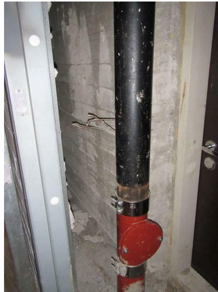
Kuva 29. Valurautaviemäri, jonka alaosa on uusittu.
