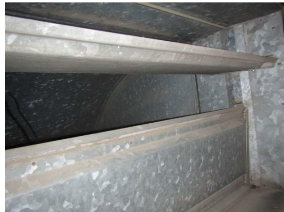
Kuva 38. Sulkupellin alempi säle ei liiku.
