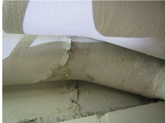
Kuva 9. Alkuperäisten eristeiden pintoja on osin rikki.
