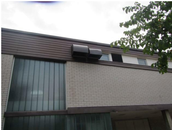
Kuva 35. Ulkoilmasäleiköt pohjoispäädyssä.
