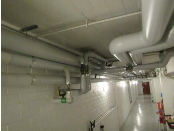
Kuva 8. Uusitut eristeet ovat hyväkuntoisia.
