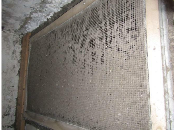
Kuva 40. Metalliverkko on melkein tukossa.
