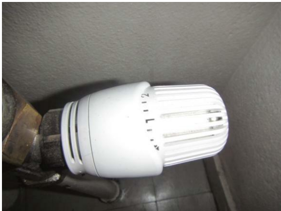
Kuva 13. Patteriventtiilit on kattavasti uusittu.
