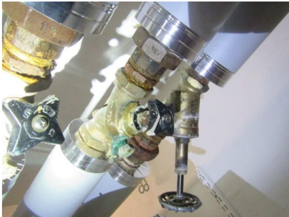
Kuva 10. Alkuperäisten linjaventtiilien toimintakunto on huono.
