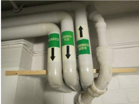
Kuva 20. Uusittuja eristeitä kellarikäytävällä.
