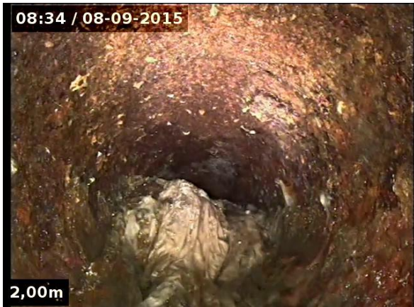
Kuva 30. Valurautaosuudessa on runsasta irtokertymää.
