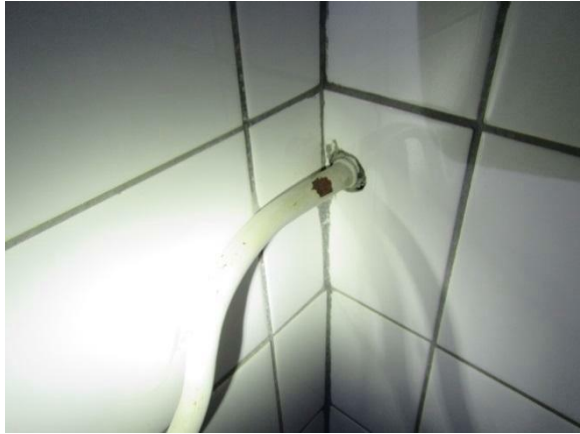
Kuva 25. Liikuntasalien suihkutilojen (2 krs.) vesijohtojen läpiviennit ovat puutteellisesti tiivistetty.
