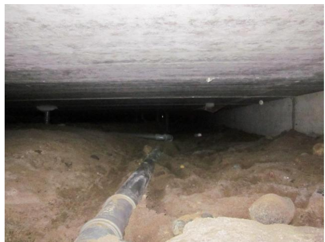
Kuva 8 Matalaa alustatilaa pohjoisen puoleisessa sivulohkossa.
