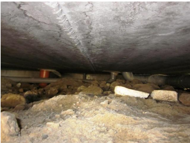
Kuva 15 Yksittäisiä polystyreenilevyn kappaleita.
