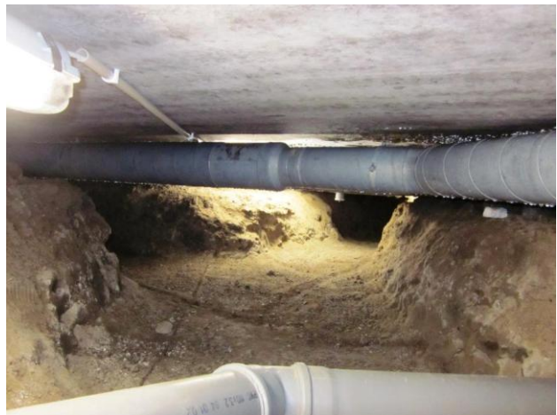
Kuva 2 Luukun kohdalta kuvattuna keskilohkon kaivantoa pohjoiseen päin.
