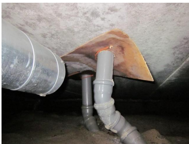
Kuva 23 Vaurioitunut muottilevy.
