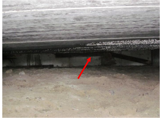
Kuva 18 Muotti-/ tukipuita päätyjen sokkelipalkeissa.
