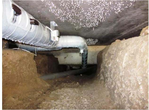
Kuva 4 Kaivantoa ja perustuspalkin alitus pohjoissivustan lohkoon.
