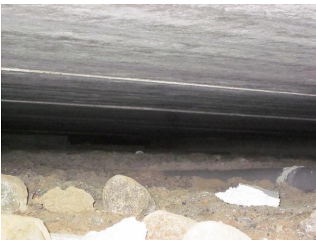
Kuva 7 Matalaa alustatilaa keskilohkon lounaan puoleisessa päädyssä.
