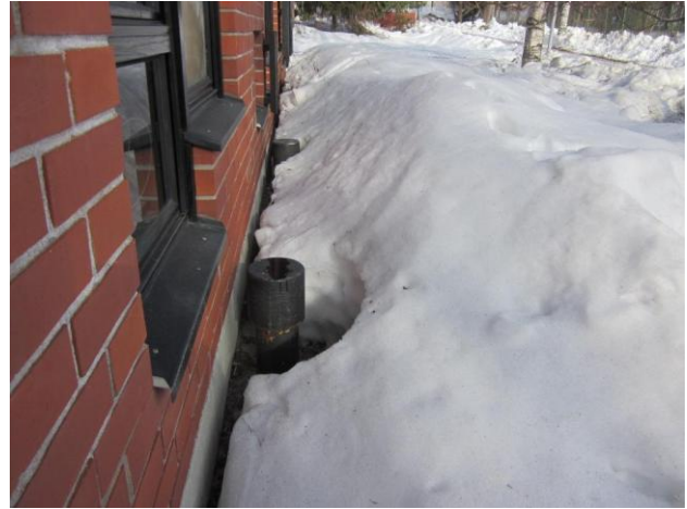
Kuva 14 Tuuletusputkia lumen alla.
