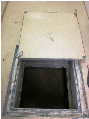
Kuva 1 Lattialuukku alustatilaan.
