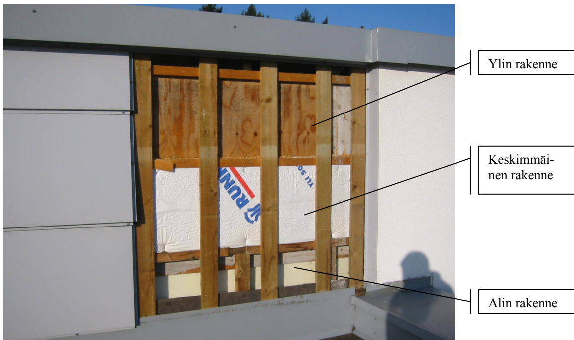
Kuva 1. Avauskohta A01-US peltikasettiverhoillun ja kuorimuurausverhoillun ulkoseinän rajakohdassa.
