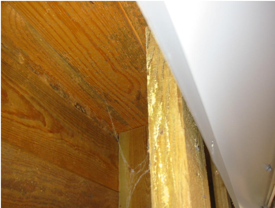
Kuva 3. Räystäsrakenne ylemmän katteen suuntaan kuvattuna.
