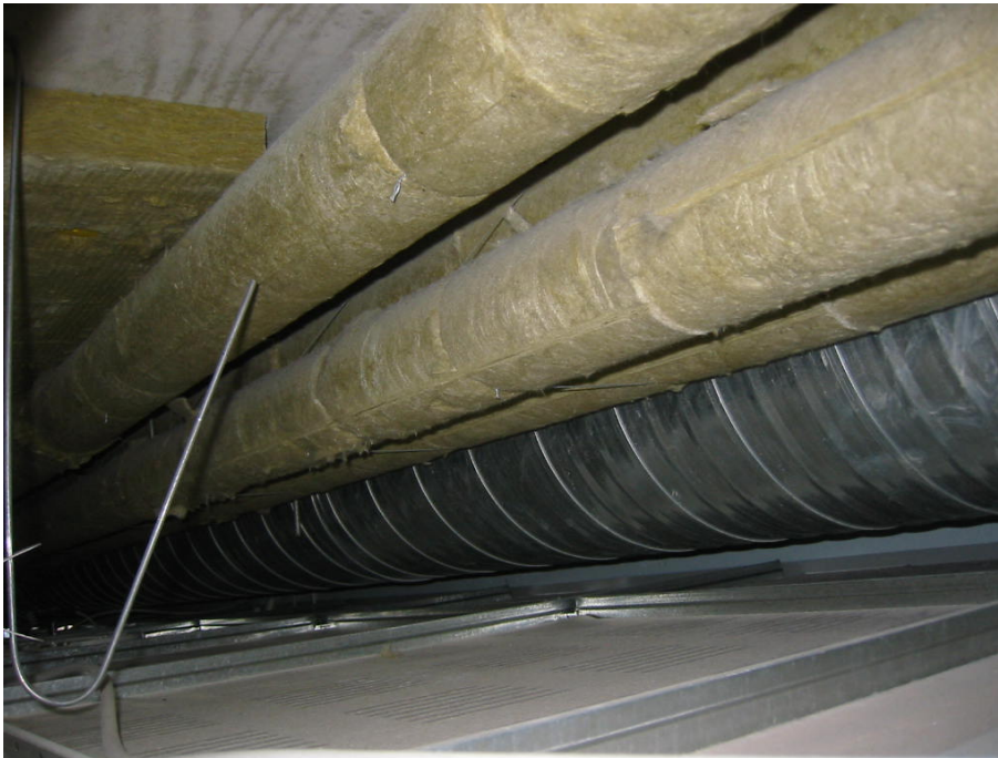
Kuva 2. Avauskohta A02-171, alakaton yläpuolinen onkalotila. Avauskohdasta ei ollut havaittavissa rakennepinnoilla kosteusjälkiä tai muita vastaavia merkkejä, jotka viittaisivat tapahtuneeseen vesivuotoon.
