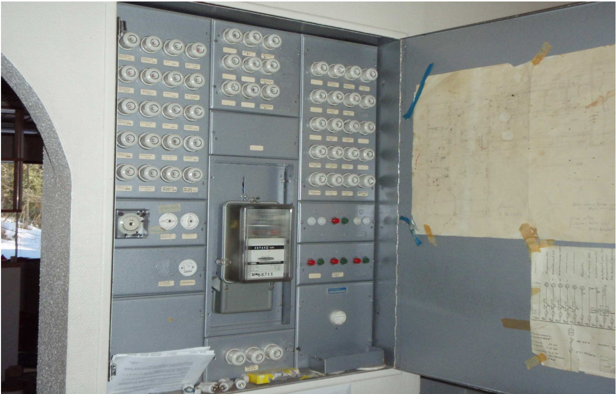
S-kuva 2. Sähköpääkeskus.
