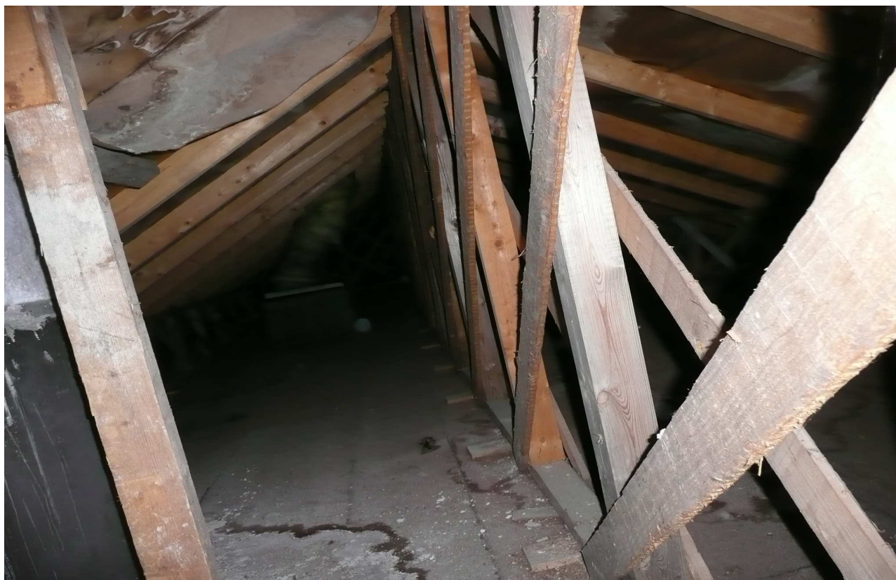
R-kuva 2. Vesikatto on alun perin ollut huopapintainen tasakatto.
