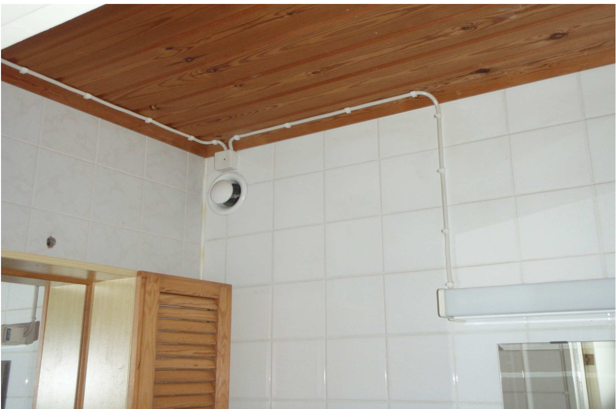
S-kuva 3. Yleiskuva lisäasennuksesta.
