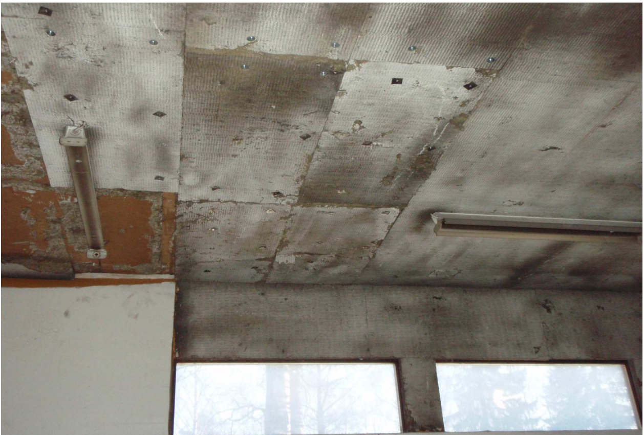
S-kuva 11. Autotallin valaistus.
