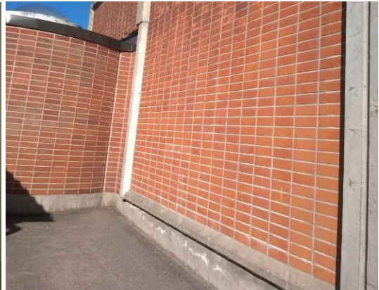
Kuvat 9 ja 10. Kosteusvaurioalue liikuntasalin eteläsivulla maan pinnan tasossa. Ulkopuolella vastaavassa kohdassa näkyy sokkelirakenteessa kosteusjälkiä.
