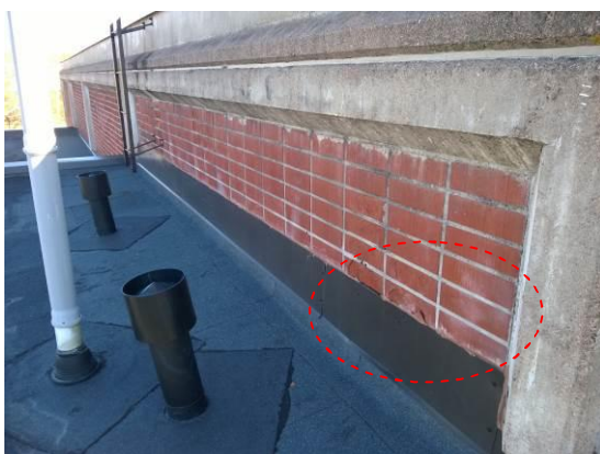
Kuvat 13 ja 14. Kermien ylösnostot liittyvät paikoitellen epätiivisti rapautuneisiin tiililaattoihin. Räystäiden myrskypeltejä puuttuu ja räystäspellitys on matala.
