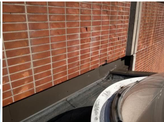
Kuvat 11 ja 12. Katon ja seinän liittymässä esiintyy kosteusjälkiä liikuntasalin viereisessä portaikossa. Katolla bitumikermin ylösnosto ja pellitys liittyy osittain rapautuneeseen, huokoiseen tiililaattapintaan. Myös elementtisaumoissa ja yläräystäässä on puutteita.
