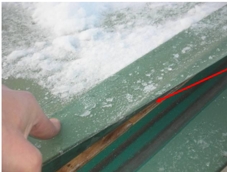
Kuva 4. Saumakaistan liimauskiinnitys on irronnut.
