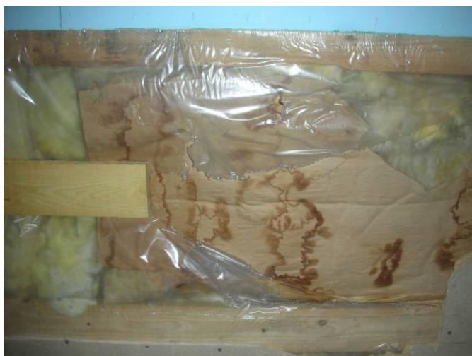
Kuva 7. Kosteusjälkiä lämmöneristeissä.
