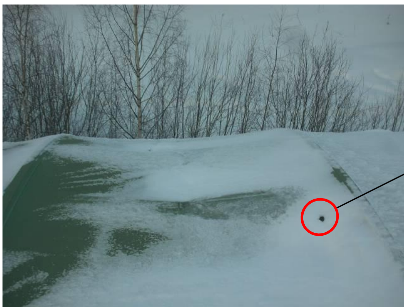
Kuva 2. Kahden kannattimen välinen PVC-kate.
