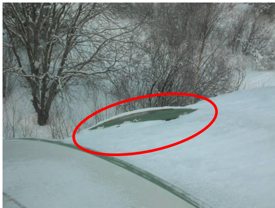
Kuvat 5. ja 6. Katteessa havaittiin isoja repeytymiä.
