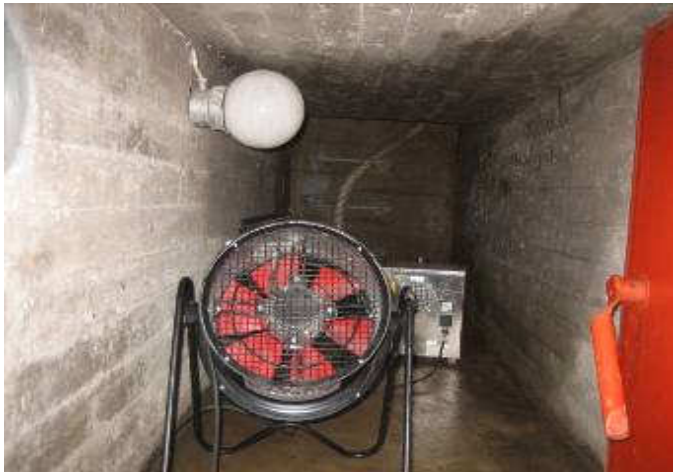
Kuva 3. Varauloskäynti sisäpuolelta, irtovedet imuroitu ja kuivatus asennettu 15.4.2009
