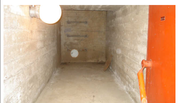
Kuva 4. Varauloskäynti sisäpuolelta, kuivatus purettu ja tila desinfioitu 20.4.2009
