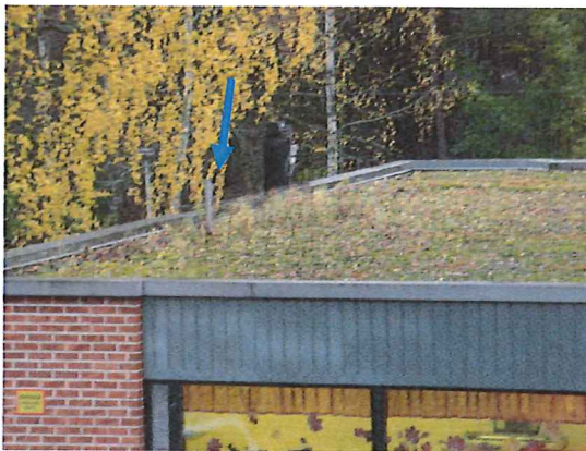
Kuva 10. Käytöstä poistettu tuuletusviemäri.
