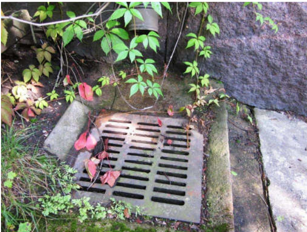
Kuva 30 Betonikivet reunakorotuksena.
