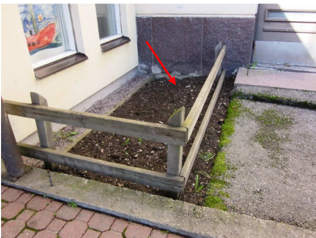
Kuva 12 Multapenkki ulottuu sokkeliin asti.
