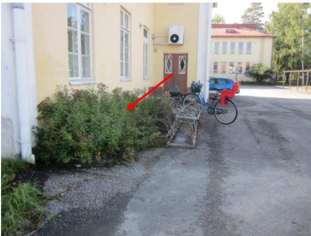
Kuva 28 Multapenkki on kiinni sokkelissa.
