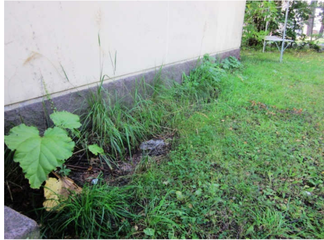
Kuva 7 Länsipäätyä. Rakennuksen vierellä nurmimaata.
