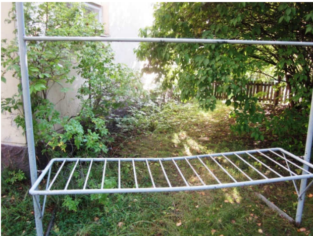
Kuva 8 Eteläsivun yläosalla runsasta kasvillisuutta.
