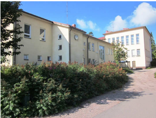
Kuva 14 Koillisen puoleisen kulman pensasistutusalue.
