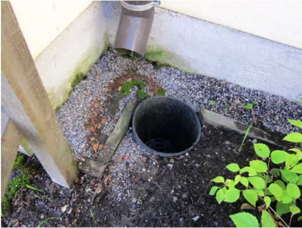
Kuva 18 Sokkelin vierellä sepelikaistale.
