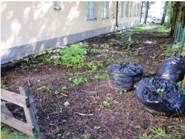
Kuva 20 Maanpinta epätasainen. Poistettu kasvillisuutta.
