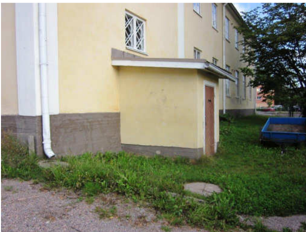
Kuva 24 Pintakallistus sisäänkäyntiä päin.
