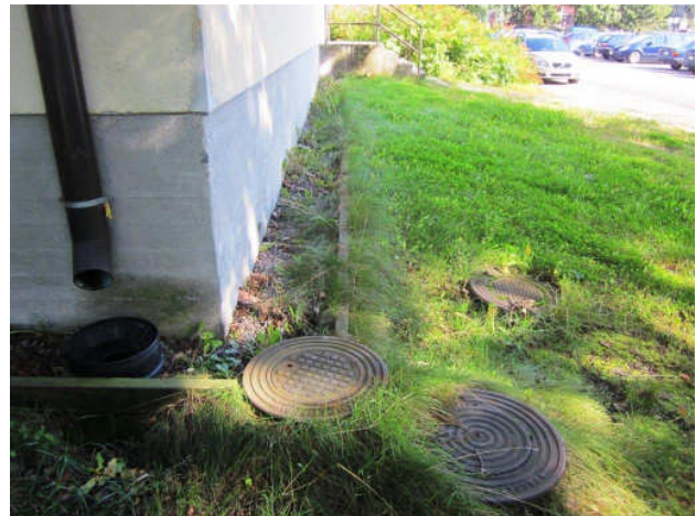
Kuva 21 Kaivojen kansiosat maanpinnan yläpuolella.
