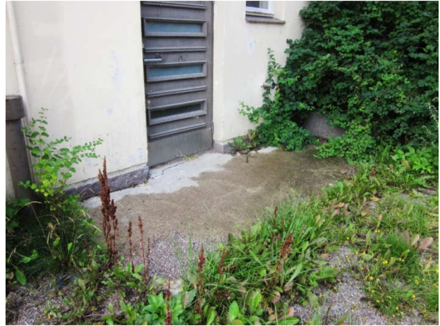
Kuva 2 Sisäänkäynnin kohdalla betonilaatta.
