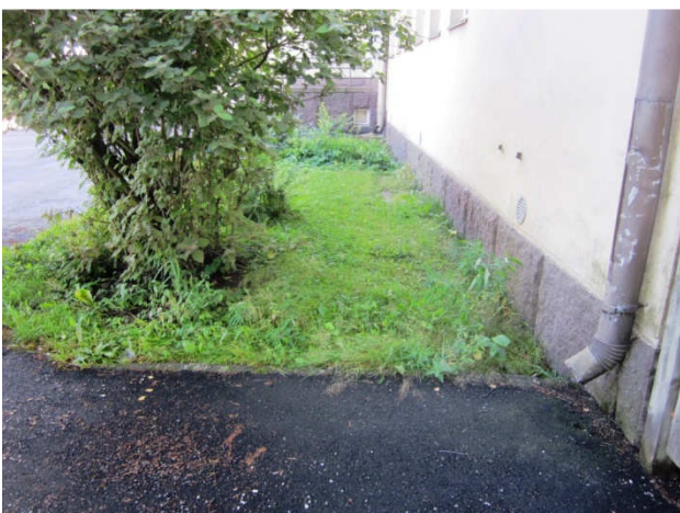
Kuva 5 Rakennuksen vierellä nurmimaata. Lähellä länsipäätä asfalttia.
