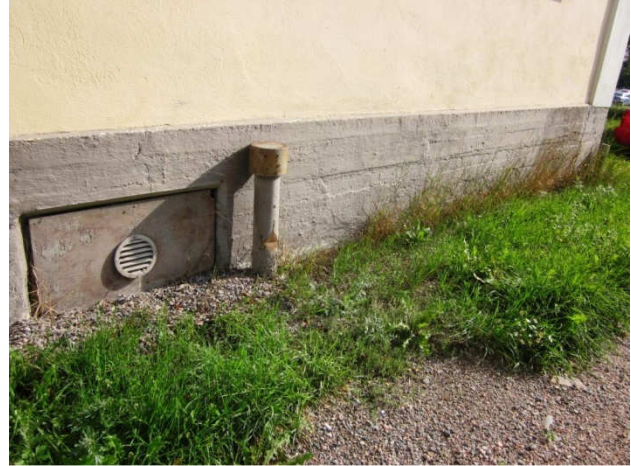
Kuva 23 Sokkelin vierellä soraa ja nurmea.
