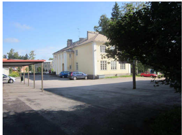
Kuva 29 Piha-alue asfalttia. Sadevesikaivo ainoastaan kulmalla, johon myös kattosadevesiä ohjataan.
