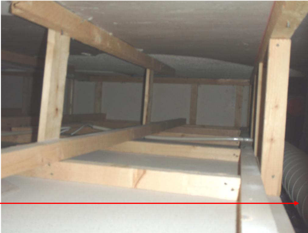
KUVA 7. On otettu siivouskomeron no:115 alakaton tarkastusluukusta, ET Hallin no:111 välikatosta Wc:lle päin.
