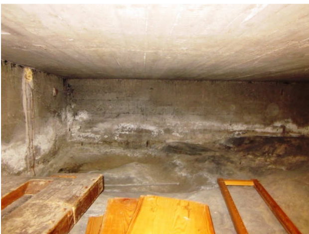
Kuva 3 Länsipäätä etelän puoleisessa lohkossa.
