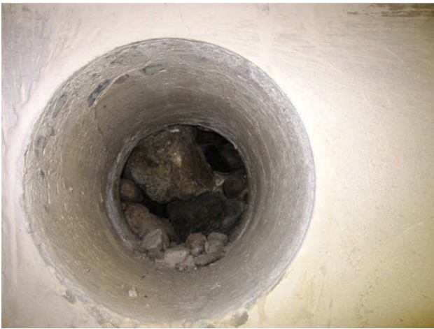
Kuva 7 Porausreikä pääsisäänkäynnin portaan alle.
