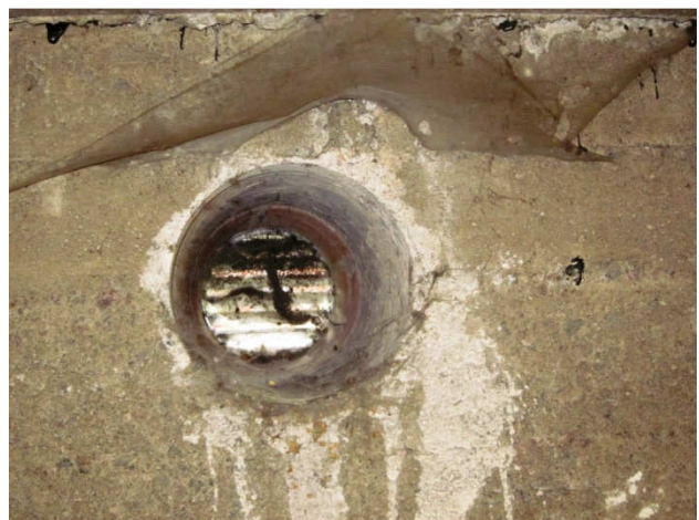
Kuva 4 Perusmuureissa korvausilmaventtiileitä.
