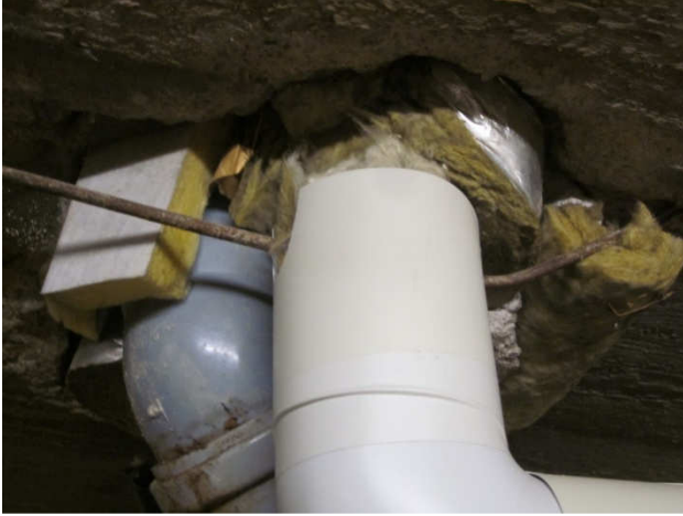
Kuva 5 Tiivistämätön putkiläpivienti.
