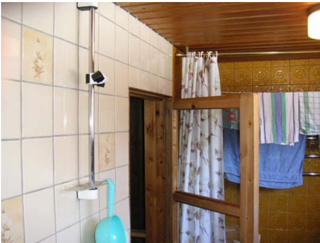
Kuva 2. Osa kylpyhuoneen seinästä on uusittu
