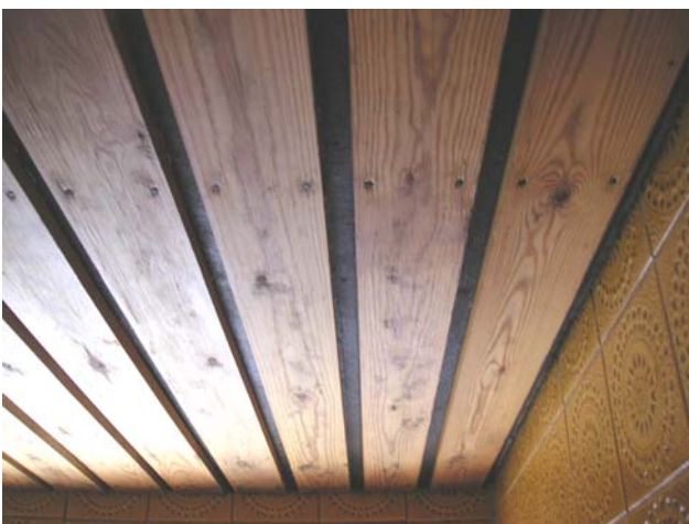
Kuva 3. Kylpyhuoneen harvalaudoituksen alla on lastulevy
