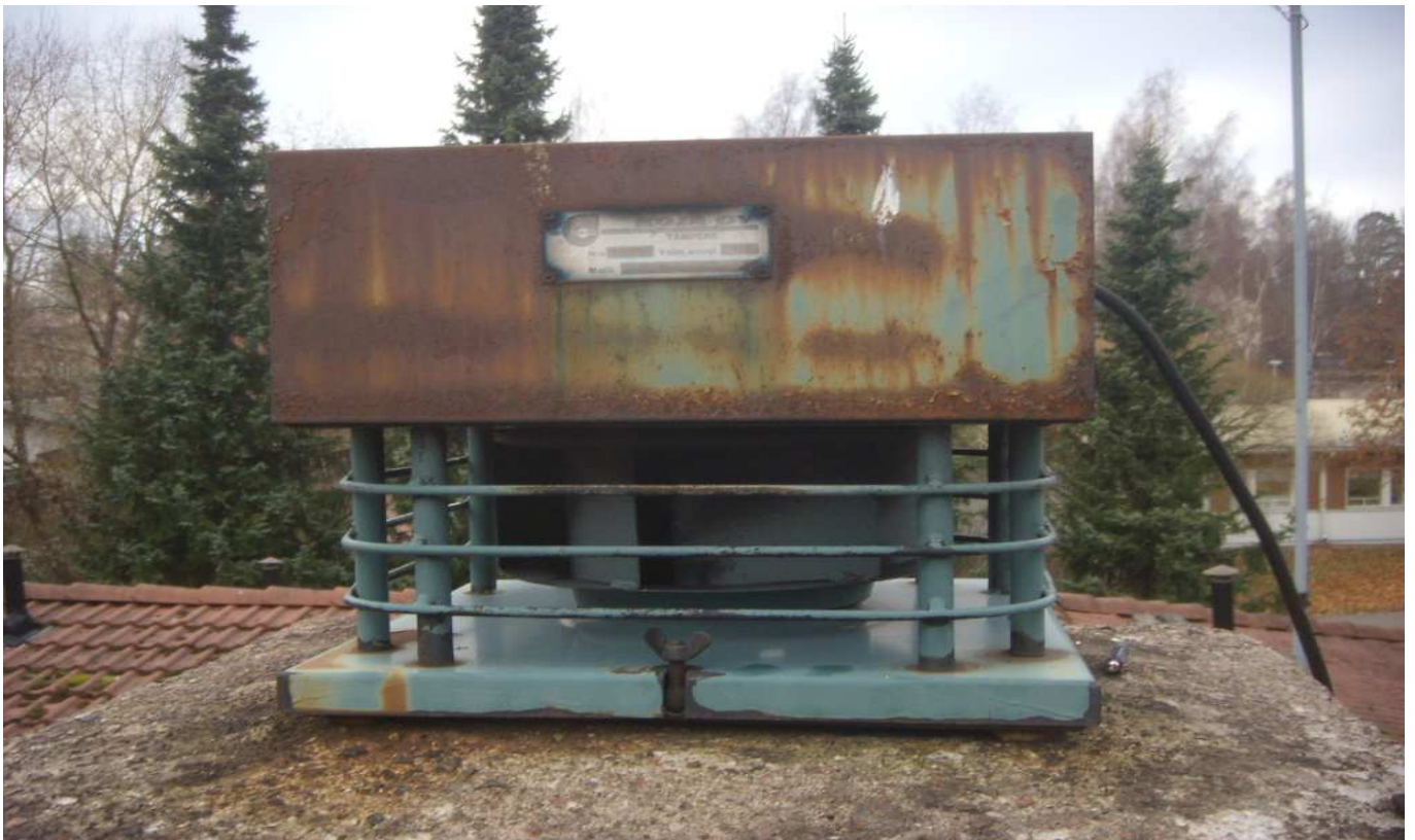
KUVA 6. Yleiskuva vesikatolla olevasta huippumurista.
