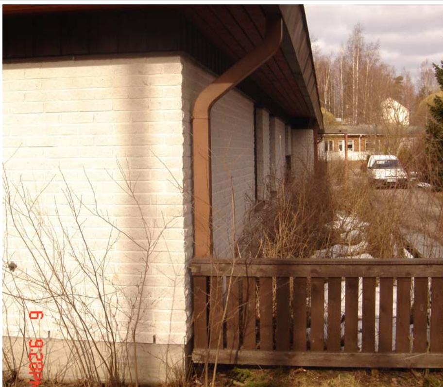
KUVA 103 Tiilijulkisivu kunnossa, kasvillisuutta seinän vieressä.
