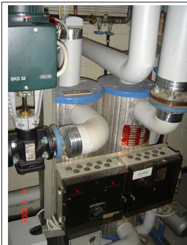
KUVA 201 Kaukolämmön alakeskus
