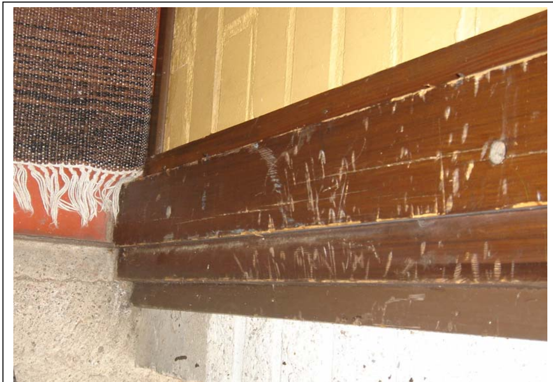
KUVA 106 Puisten ulko-ovien karmit kolhuilla
