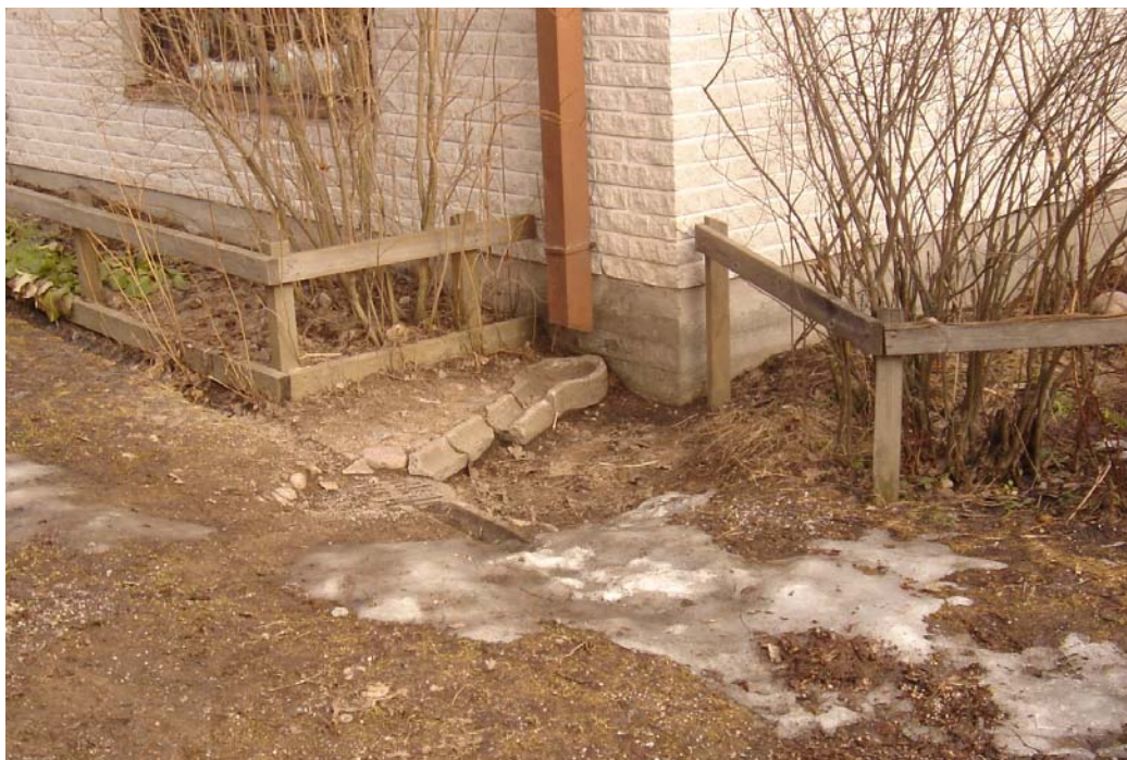
KUVA 102 Kattovedet valuvat seinän viereen
