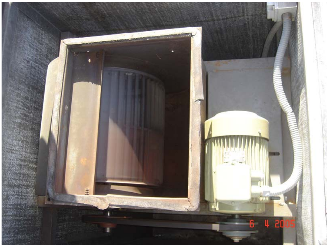
KUVA 206 Puhdistus sisältä huollon yhteydessä
