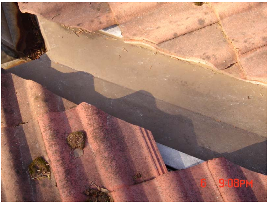
KUVA 107 Kattotiliä rikki monin paikoin
