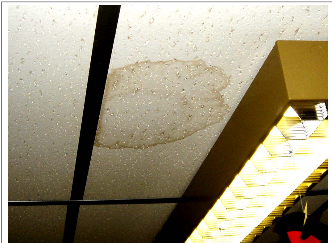
KUVA 112 Alakattossa vesivuotojälki
