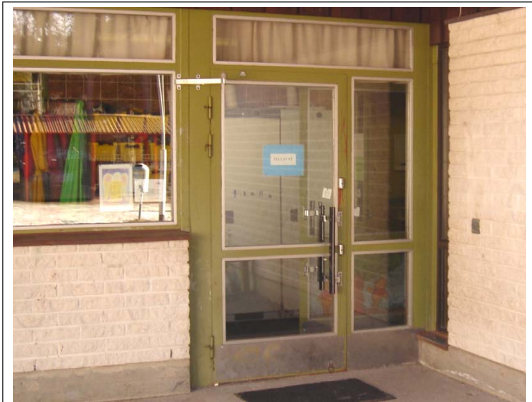
KUVA 105 Ulko-ovet kolhaiset ja paikoin alkavaa ruostevikaa
