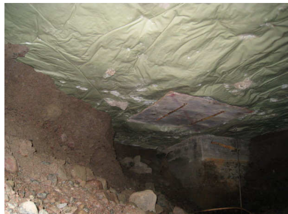
Kuva 10 Käytävän 007 alustan vieressä oleva alustatila. Betoniseinä on tod.näk uima-altaan kulma. Katossa on vaneria.
