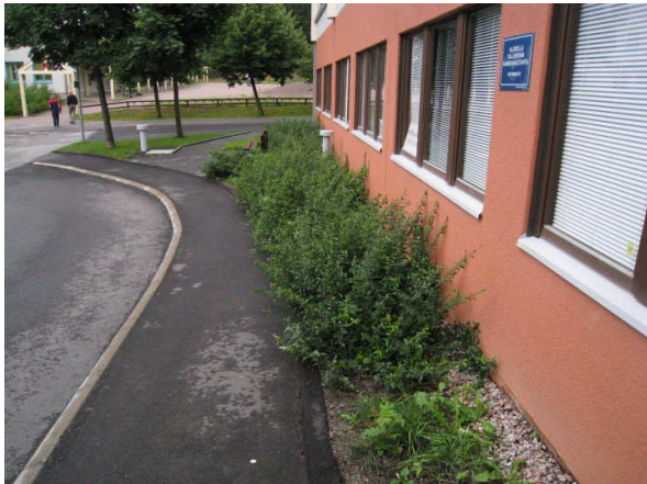
Kuva 1 Yleiskuva rakennuksen viereltä. Sokkelin vieressä on sepelikaista ja perusmuuria vasten on sokkelilevy.
