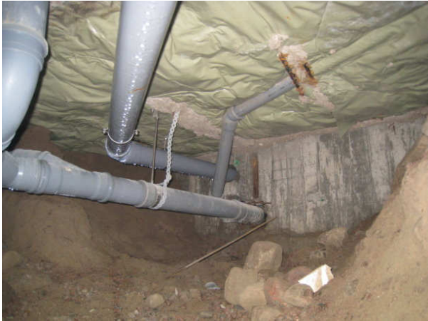
Kuva 31 B-osa/ Luukku B3 käytävä 060 alla.
