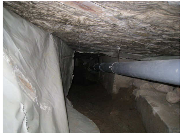
Kuva 16 A-osa/ Luukku A4 kahvion alla kuva K-moduulilinjalta. Kaivanto on ahdas.
