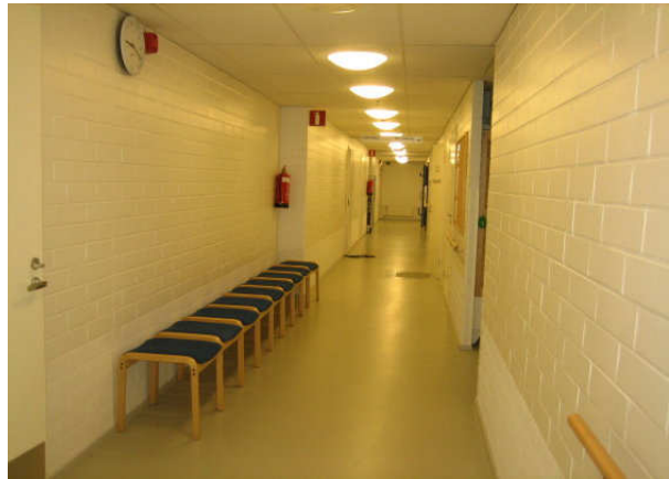
Kuva 2 Yleiskuva A-osan kellarin käytävältä, jossa on luukkuja ja tarkastuskaivojen kansia.
