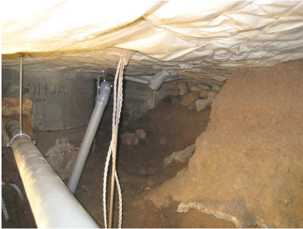
Kuva 25 B-osa/ Luukku B2 kohdalta kuva hilj.huone 044 alla olevaa bet.kaivoa.
