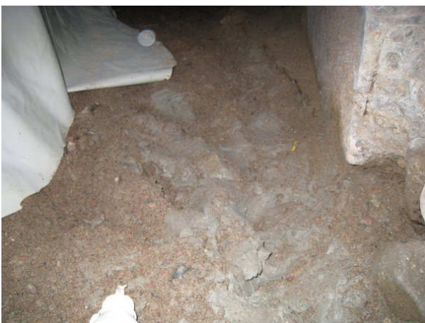
Kuva 17 A-osa/ Luukku A4 K-moduulilinjan vierellä hiekkaa on ohuelta ja alla on märkää savea.
