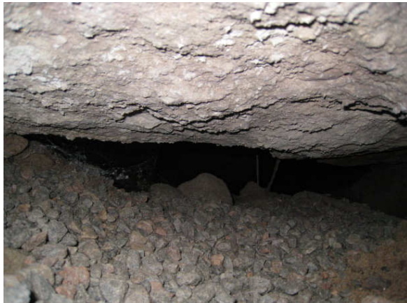
Kuva 9 Luokku A1 puolelta käytävän 007 reunapalkin ali oli matala rako, jonka ali otettiin kuva 10.
