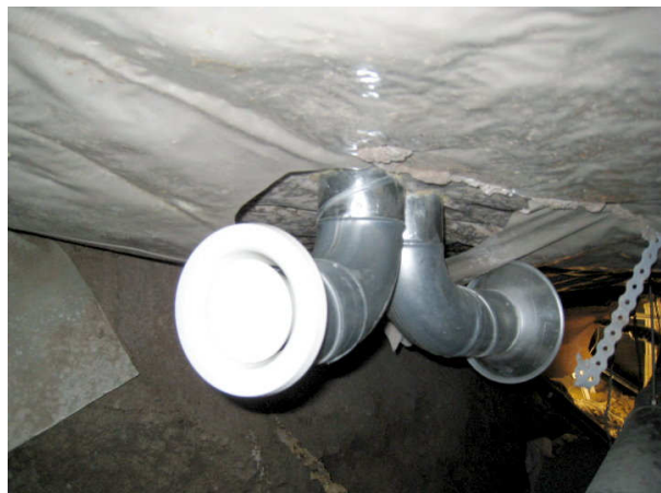
Kuva 6 Luukku A1 lähellä A-osan ilmanpoistoputkien päät.
