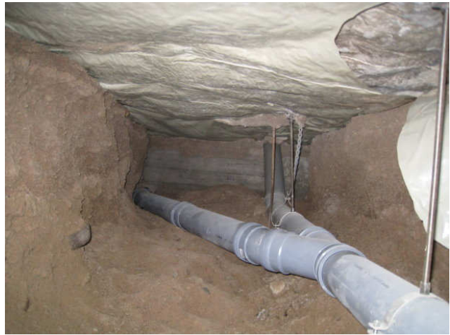
Kuva 14 A-osa/ Luukku 3 tavarahissin takana vaate-tilan 033 alla, kuva kahvion 027 suuntaan.
