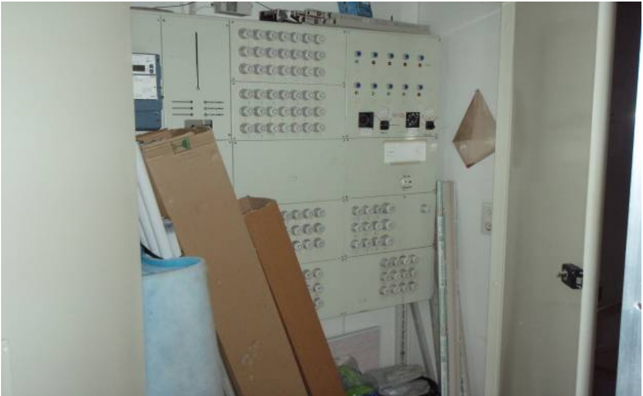
S-KUVA 3. Sähköpääkeskus
