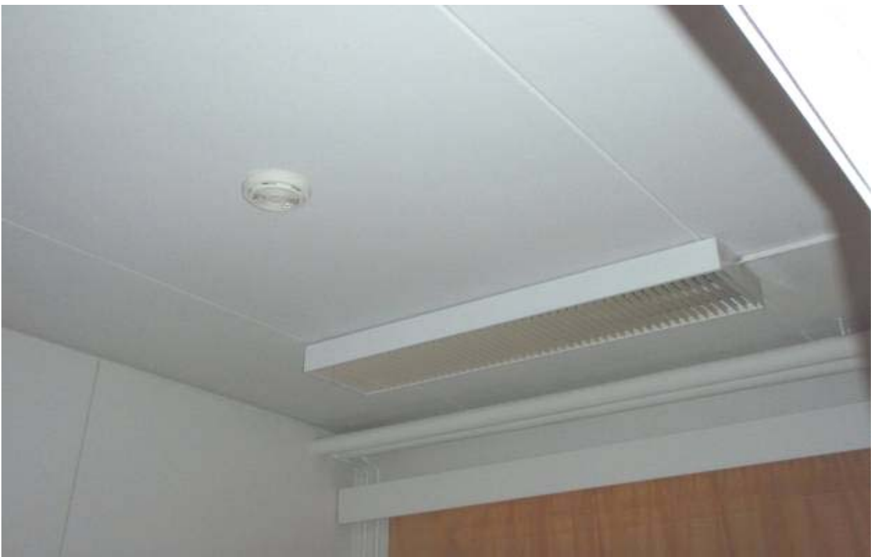
S-KUVA 4. Huoneiden valaistus ja palovaroin
