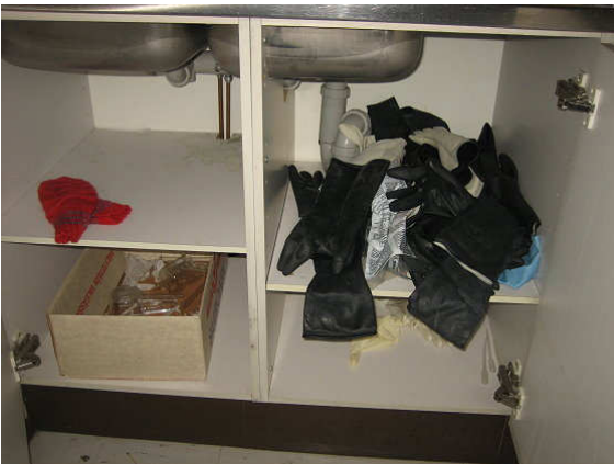
Kuva 13 Satunnaisesti tarkistetuissa luokahuoneiden allaskaapeissa ei havaittu merkittäviä vaurioita.
