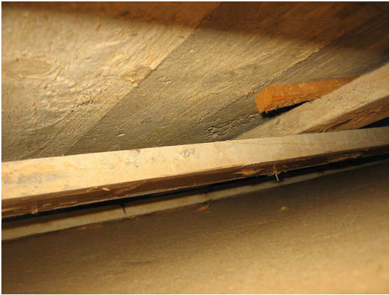
Kuva 11 Kuva kattoverhouslevyn yläpuolelta (kts. kuva 10). Tällä kohdalla vesivuotojälkiä ei havaittu.
