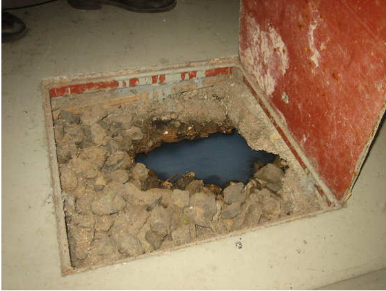
Kuva 15 Rakennuksen 2 maalaustilan lattiassa oleva luukku. Pohjalla sinistä nestettä.
