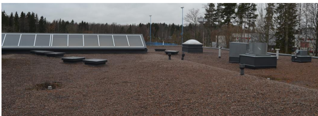
Kuva 3. Vegassa on useita kattoikkunoita. Katolla ei havaittu puutteita tai merkittävästi roskaa. Kattokaivot olivat siistit ja kaadot riittävät.
