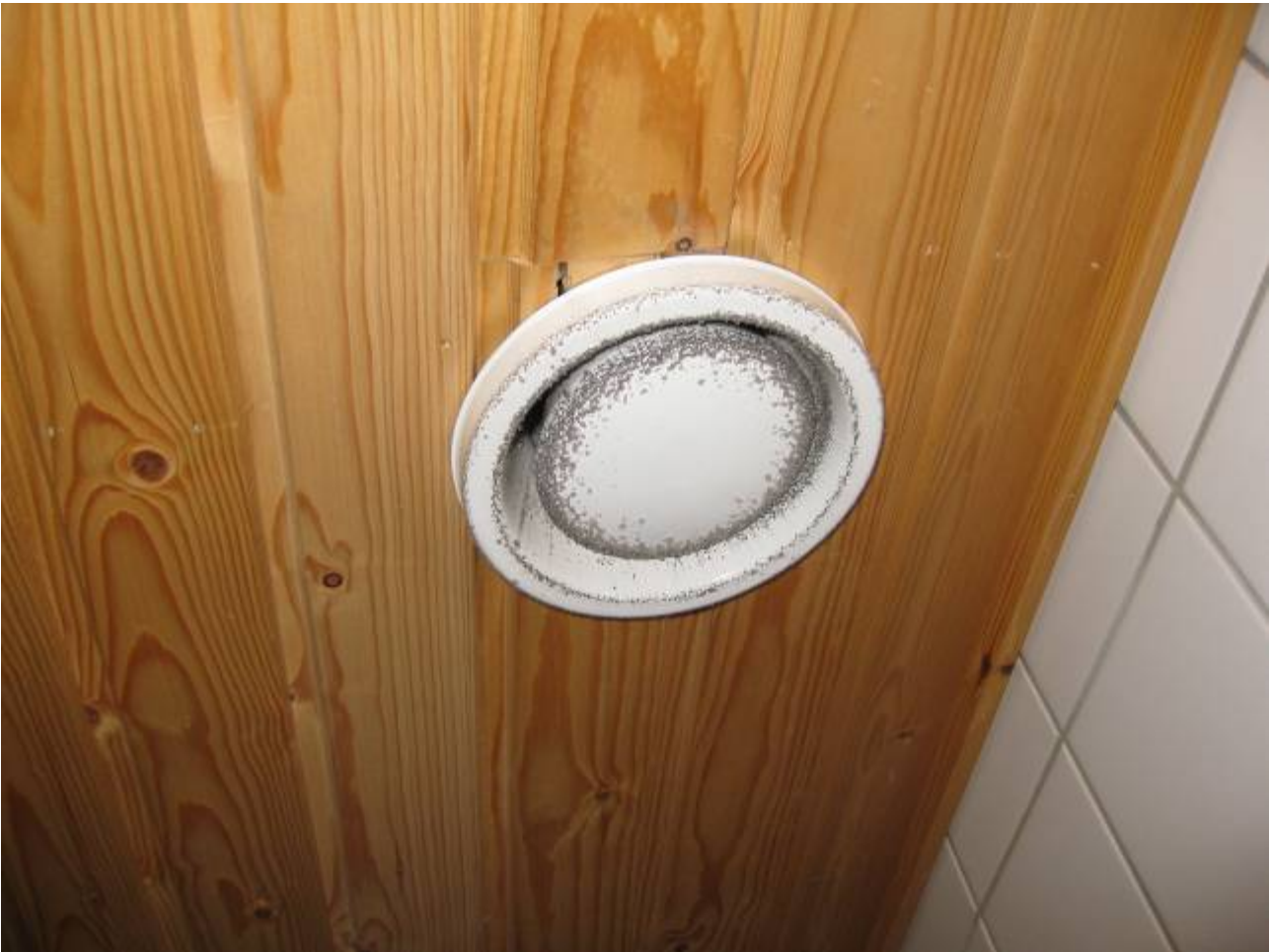
LVI-kuva 6. Pääte-elimet olivat paikoin erittäin likaiset.
