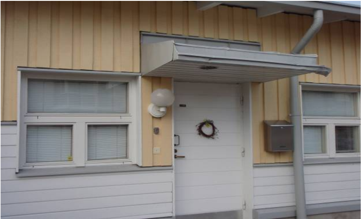
S-KUVA 1. Sisäänkäynnin valaistus
