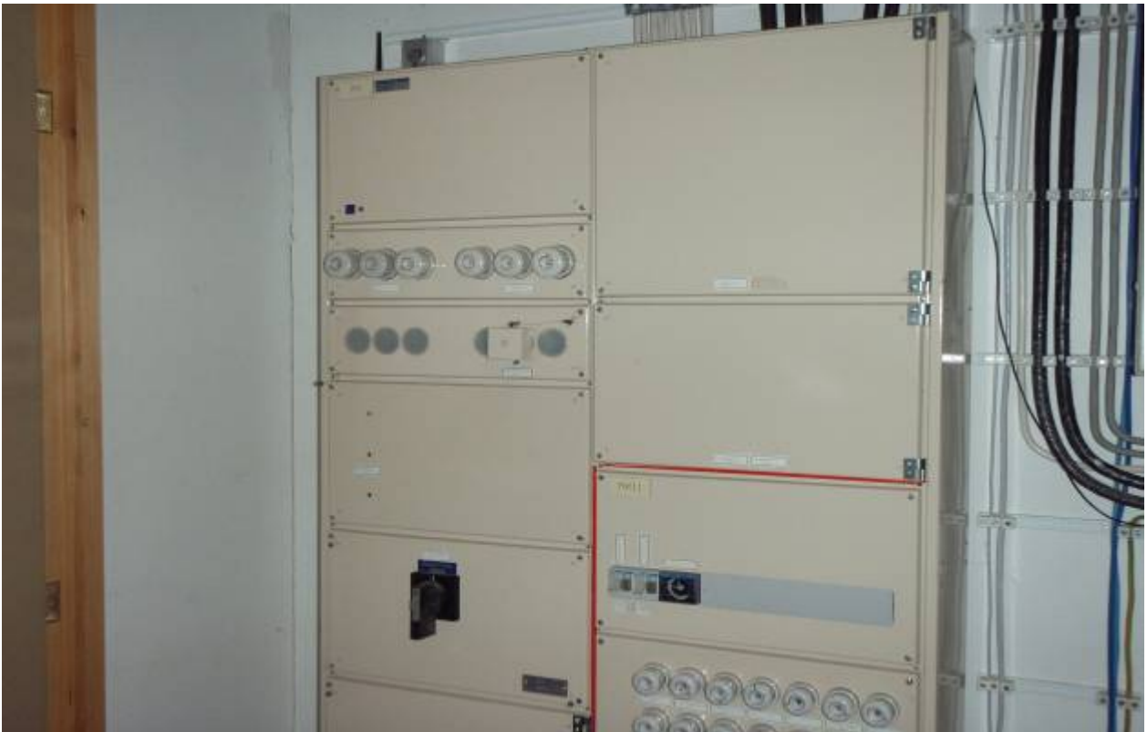
S-KUVA 3. Sähköpääkeskus
