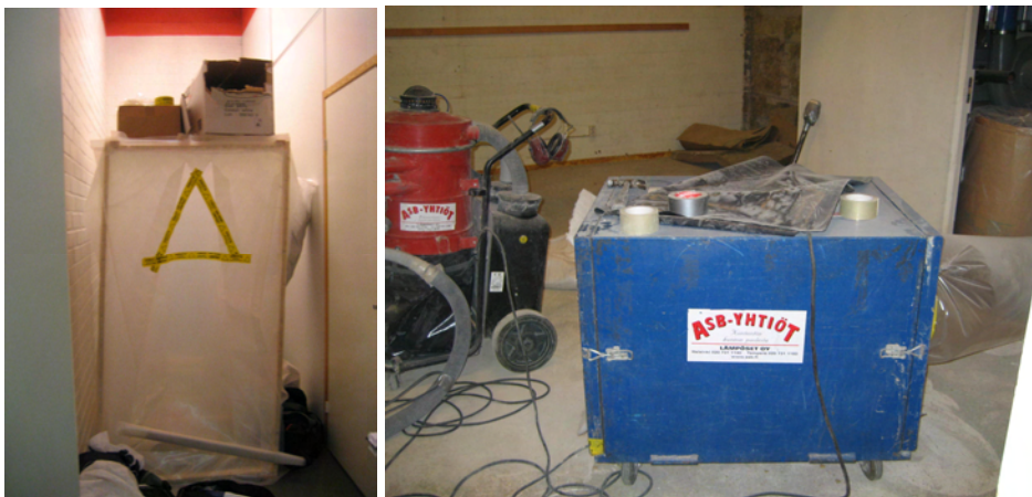
Kuvat 43 ja 44. Valokuvat Martinlaakson koulun Studio –tilana olevan väestönsuojan asbestipurkutöiden alipaineistusjärjestelyistä.
