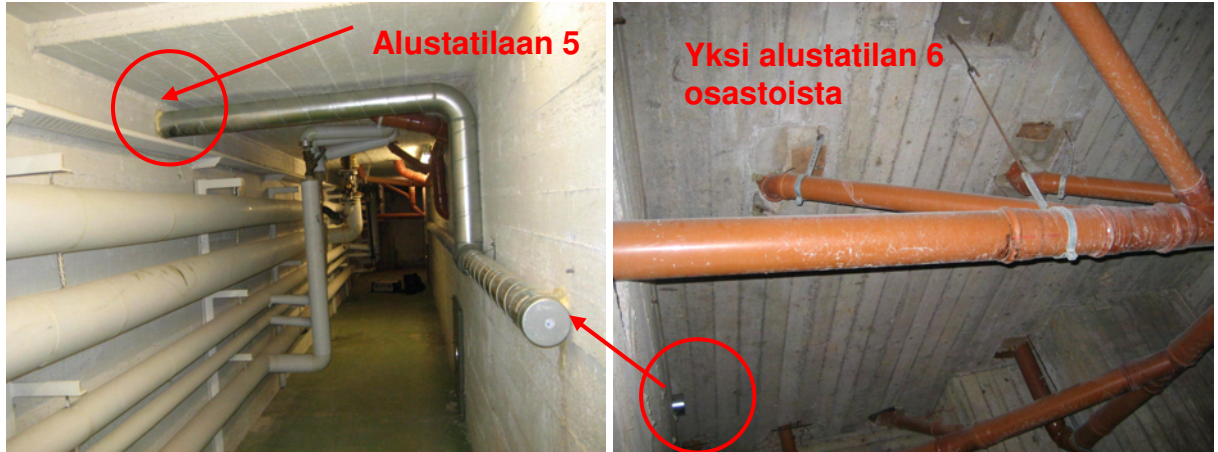
Kuvat 26 ja 27. Vasemmalla kuva alustatilojen 5 ja 6 välissä sijaitsevasta putkikanaalista ja oikealla kuva yhdestä alustatilan 6 osastosta.
