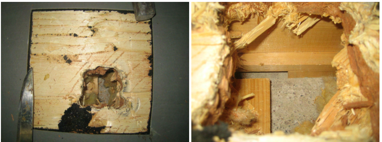
Kuvat 41 ja 42. Valokuvat Martinlaakson koulun liikuntasalin alapohjarakenteen rakenneavauksesta 1.
