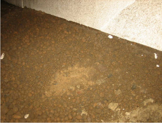
Kuva 13 Sokkelipalkkien vierillä kevytsorakeroksen vahvuus pienenee. Pinta kostea.
