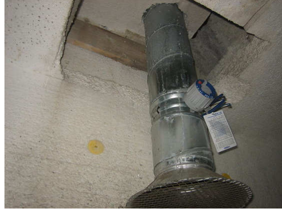
Kuva 8 A- ja B -osilla on koneellinen poistoilmanvaihto.
