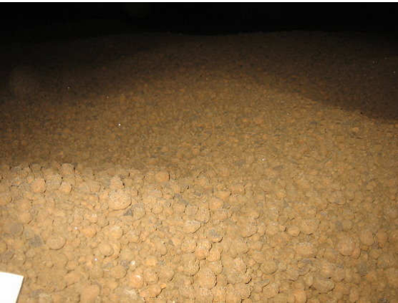
Kuva 9 B-osalla on kevytsoran pinnalla on jäähileitä.
