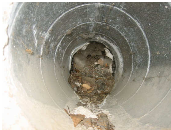
Kuva 5 Keskilohkon terassin puoleisen sivusta korvausilmareitti, joka on osittain tukossa.
