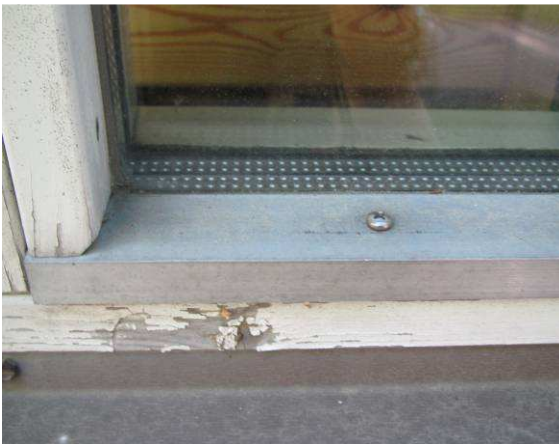
Kulumaa ja hilseily ikkunoiden maalipinnoissa Ikkunat ovat pääosin lämpölasielementtejä
