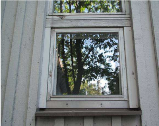
Rakennuksen ikkunat ovat alkuperäisiä puuikkunoita Puutteita ikkunapellityksissä
