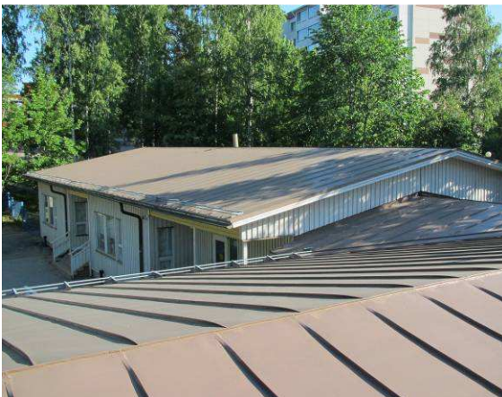
Yleiskuvaa vesikatolta, katemateriaali on konesaumattu peltikate
