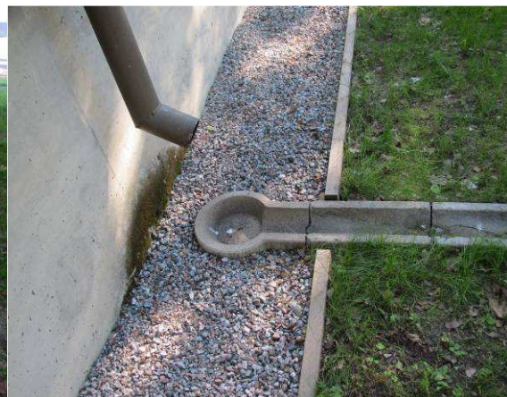
Kattovedet on ohjattu pois rakennuksen vierustalta osin pintakourujen avulla
