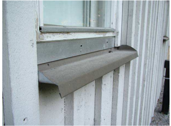
Rakennuksen ikkunat ovat alkuperäisiä puuikkunoita Puutteita ikkunapellityksissä
