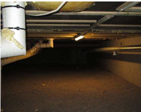
Kuvaa alapohjatilasta, kosteusongelmia ei havaittu
