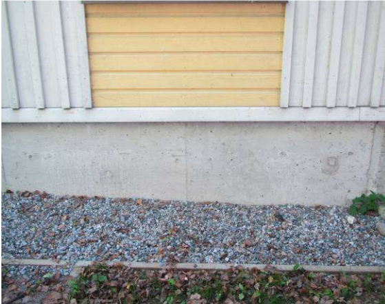
Betonisokkelit ovat tyydyttävässä kunnossa
