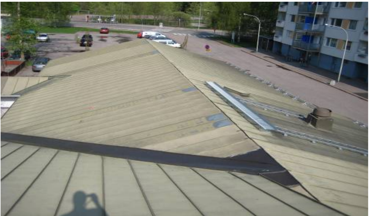
RAK-KUVA 10. Katerakenteeseen on kohdistunut kunnostustoimenpiteitä viimevuosien aikana.
