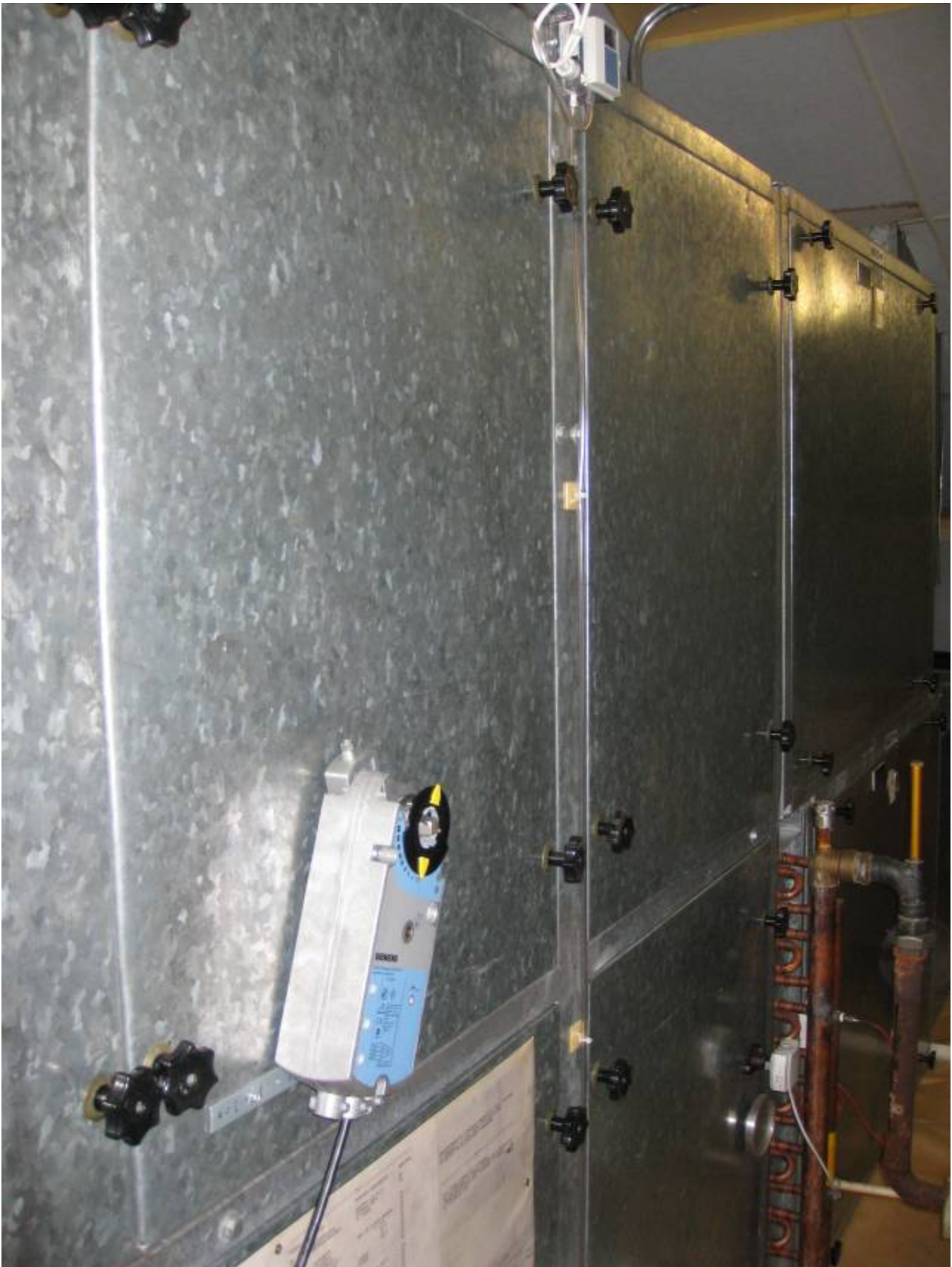
LVI-kuva 6. Yleiskuva IV- konehuoneesta.
