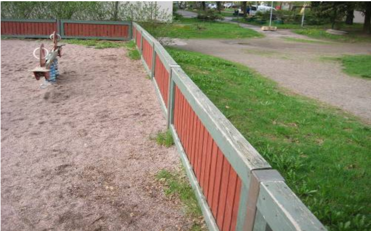
RAK-KUVA 3. Kohteesta saatujen tietojen mukaisesti leikkialueen aita uusitaan v. 2010 kesällä vastaamaan nykyisiä ko. rakenteelle asetettuja vaatimuksia.
