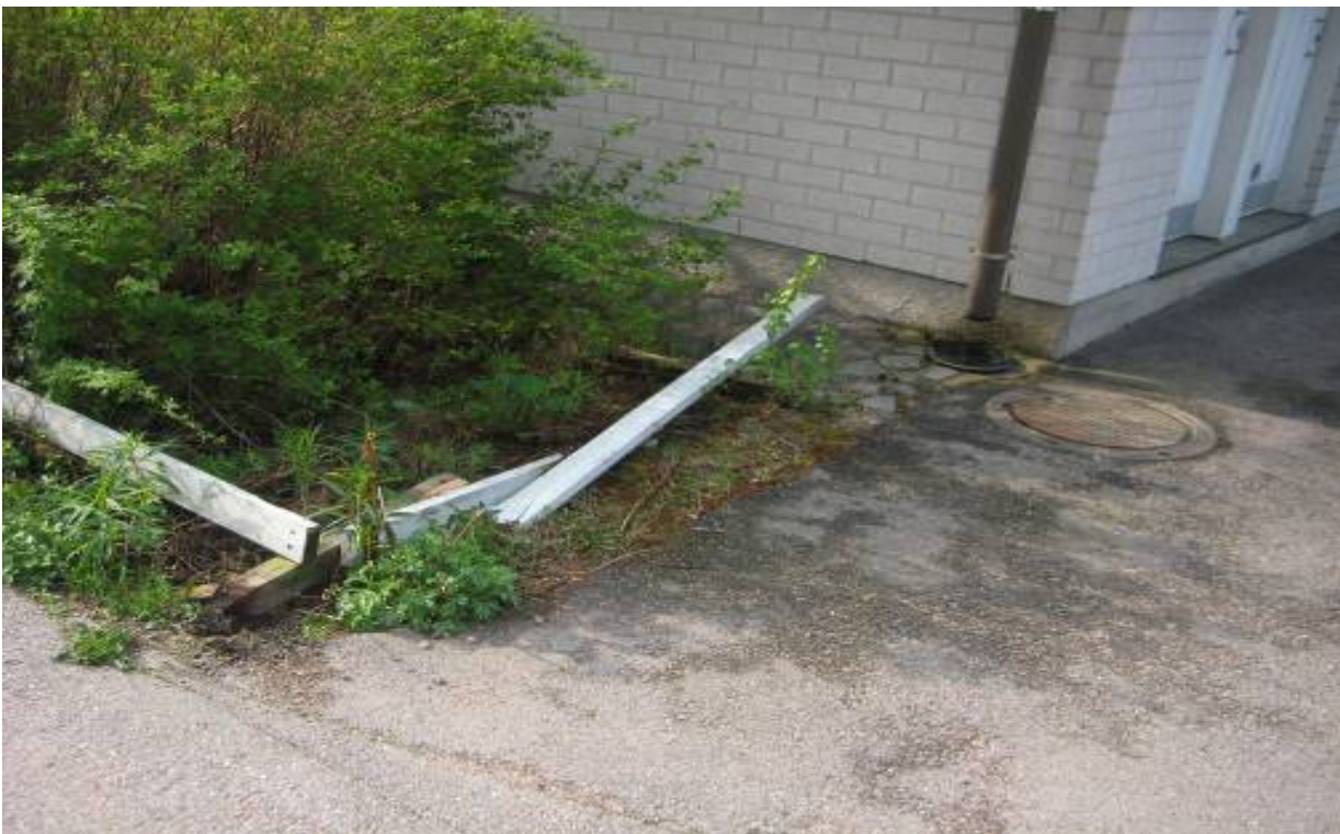
RAK-KUVA 4. Muut aitarakenteet arvioitiin kunnostettavan leikkialueen aitarakenteiden kunnostustöiden yhteydessä.
