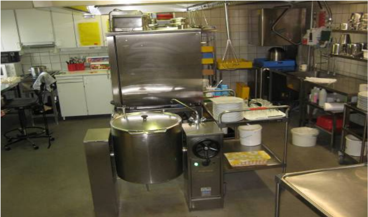
RAK-KUVA 13. Rakennukseen liittyy valmistuskeittiö joka on pääosin jakelukeittiökäytössä.
