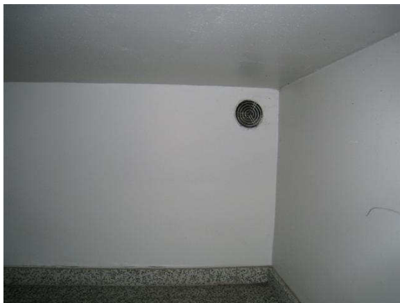
Kuva 5 Porras 1/ 0-kerros välitason alla IV-tuloilmaventtiili (11,8 °C, 44 %RH, 6,3 g/m 3 ), vieressä on hissikuilun seinä.
