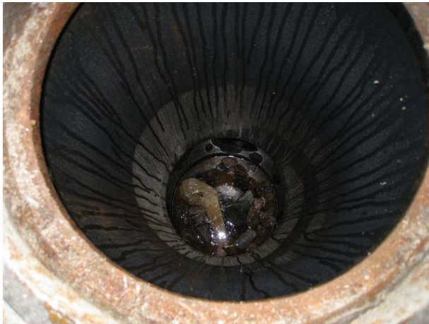
Kuva 31 So- tarkastuskaivo tilan 117/ sulkutilan edustalla, syvyys vesipintaan on n. 1,2 metriä.
