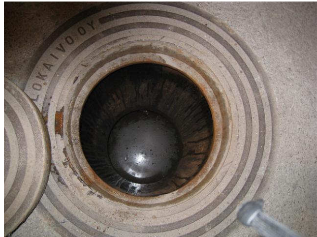
Kuva 32 So-tarkastuskaivo tilan 117 ulkokulmalla, syvyys vesipintaan on n. 0,8 metriä.
