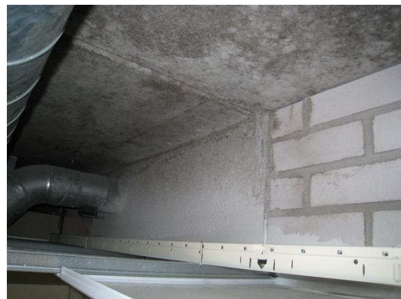
Kuva 6 Käytävä 012/ 0-kr, VSS/ 022 alaslaskutilla ja katon paikallavalu sekä ontelolaatat kylmiötilojen 133 ja 134 alla.
