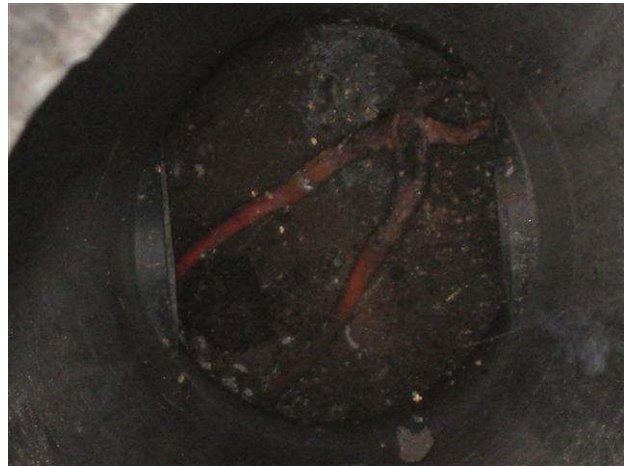
Kuva 26 Salaojakaivon pohja tilojen 122-124 kulmalla. Korkeero kansi-pohja n. 3,55 metriä. Pohjalla oli pihdit, putkia 2 kpl.
