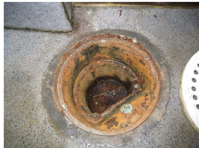
Kuva 16 134/ ong.jäte lattiakaivo on valurautaa ja viileä (4,3 °C) pohja on syvällä.
