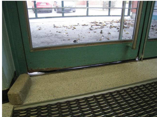
Kuva 20 Tilan 124/ tav.vast.otto ulko-oven rako. Ovimatton syvennyksen kohdalla pk-arvot olivat alemmat kuin muovim.alueella.
