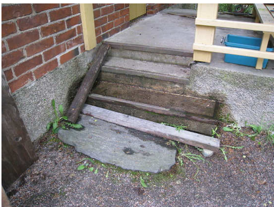
Kuva 9 Portaat kastuvat sateella pitäen sokkelin kosteutta yllä.
