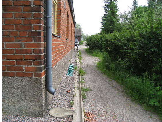
Kuva 2 Betonikourua rakennuksen pituussuuntaisella eteläsivustalla.
