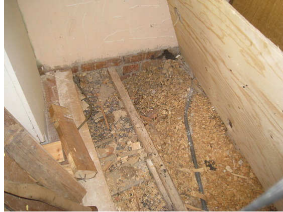
Kuva 12 Rakenneavauskohta 2.kerrosen pienen asunnon keittiössä.
