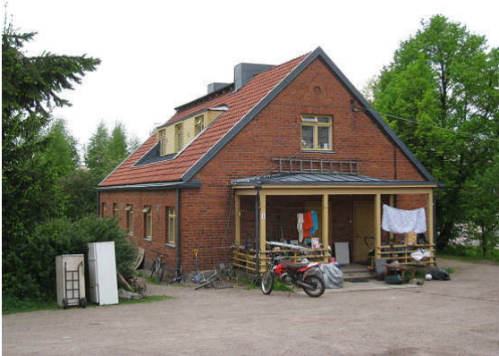
Kuva 1 Rakennus sijaitsee loivassa mäessä.
