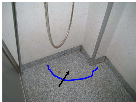
Kuva 22 Pintakosteus on korkea suihkunurkassa.
