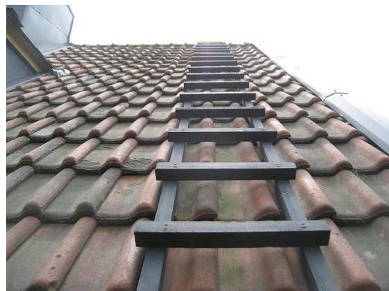
Kuva 10 Puurakenteinen lapetikas.
