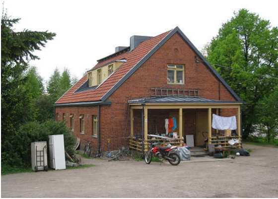
Kuva 1 Rakennus sijaitsee loivassa mäessä.
