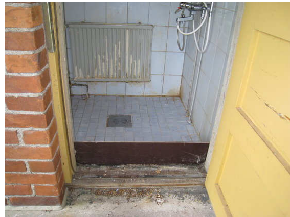
Kuva 20 Ulko-oven kynnyksen ja suihkutilan välissä filmivaneria.
