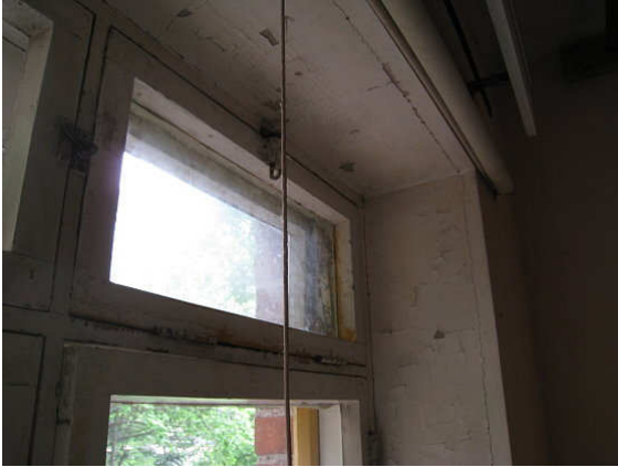
Kuva 17 Ikkunapielien maali-/ rappauspinnat hilseilevät 1.kerrosen KHH-tilassa.
