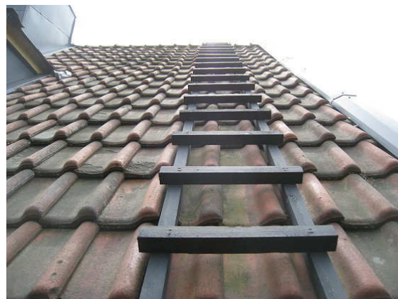
Kuva 10 Puurakenteinen lapetikas.
