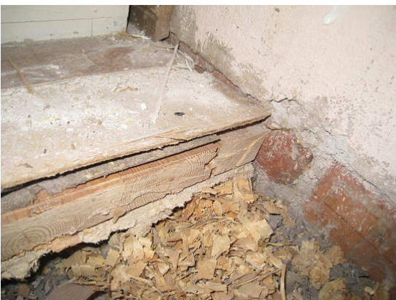
Kuva 15 Materiaalinäyte 2.kerrosen rakenneavauskohdalta kutterilastusta ja masuunikuonasta (kts. tutkimusseloste 2009-6159).
