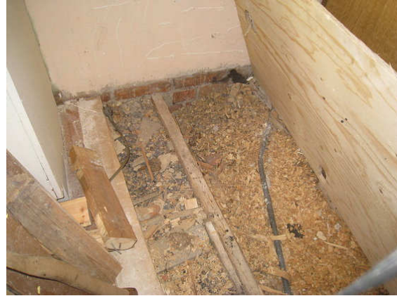
Kuva 12 Rakenneavauskohta 2.kerrosen pienen asunnon keittiössä.
