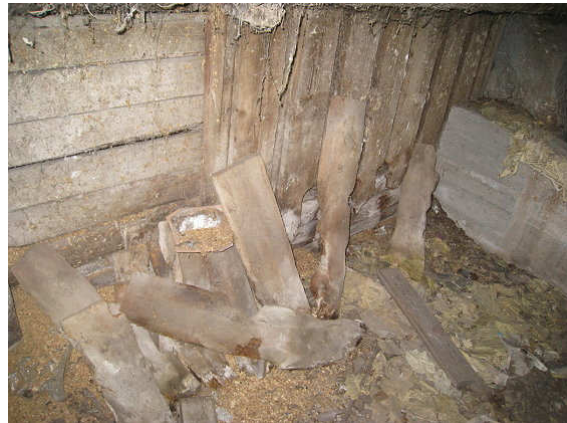
Kuva 26 Mikrobivaurioitunutta puutavaraa.
