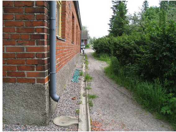
Kuva 2 Betonikourua rakennuksen pituussuuntaisella eteläsivustalla.
