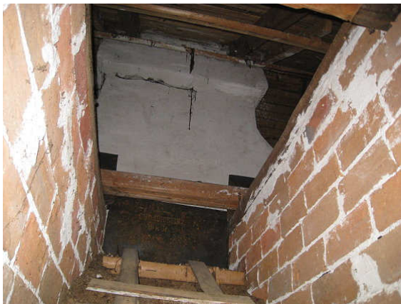
Kuva 11 Yläpohjaan kulku kapean luukun kautta.
