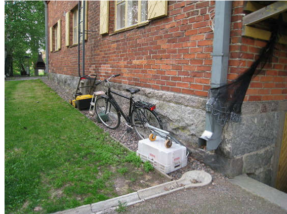
Kuva 2 Kattovesien poisto koilliskulmalta.
