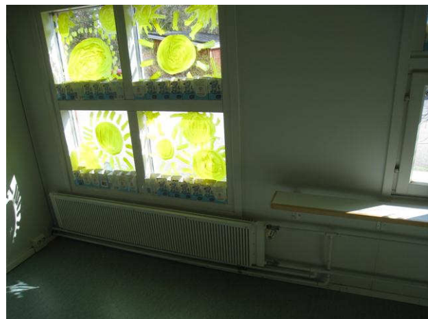
Kuva 24 Ikkunan alareuna on alhaalla salissa, radiaattoripatteri on teräväreunainen.
