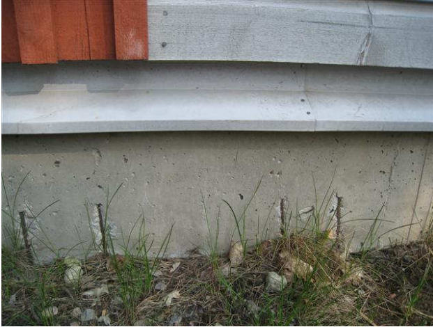
Kuva 13 Eteläpäädyssä sokkelin raudotteita on esillä.
