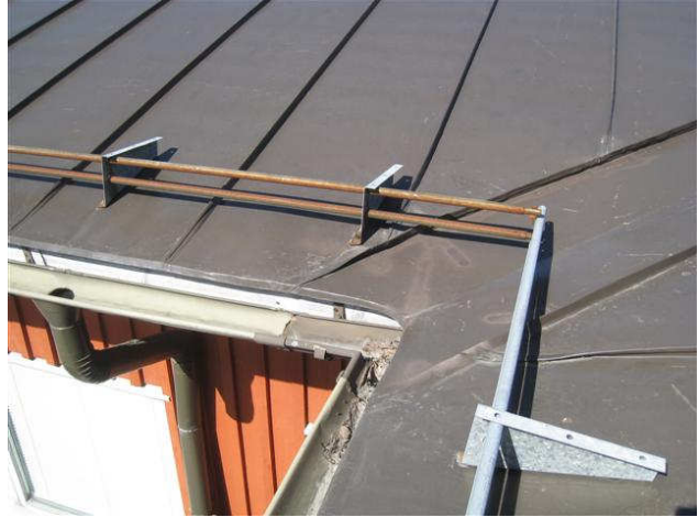
Kuva 28 Sisäpihan jiiritaite on ok, lumiesteet ovat ruosteiset vaikka on sinkitys.
