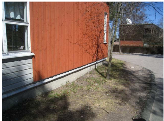
Kuva 6 Eteläpäädyssä ajojälkiä nurmella, pai- nanteita, multamaata vasten sokkelia.
