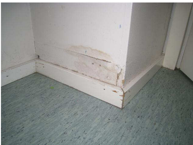
Kuva 35 Kosteusvaurioita ryhmäh. 48 kotelossa, jalkalistat ovat kuluneet.
