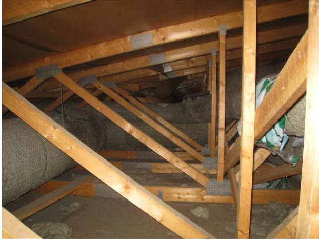
Kuva 31 Yleiskuva yläpohjaonteloon salitilojen suuntaan.
