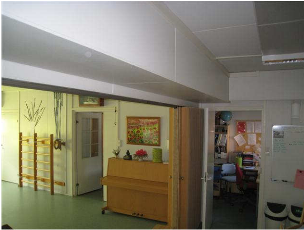
Kuva 33 Salitilan paljeoven yläreuna on painunut keskialueella n. 13 mm.
