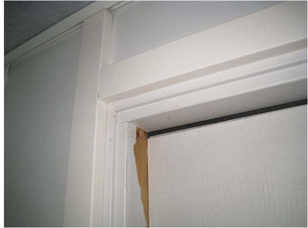
Kuva 26 Ulko-oven käyntiväliä on korjattu höylämällä.
