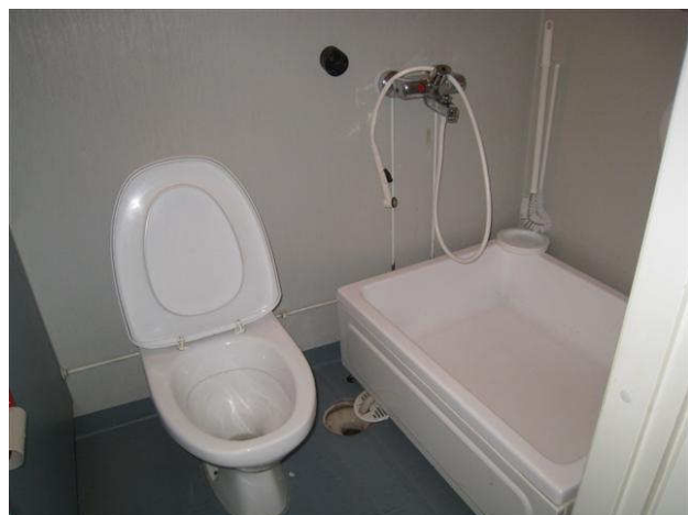
Kuva 36 Alkuperäiskuntoinen wc- suihkutila, lattianssa muovimatto, seinissä muovitapetti
