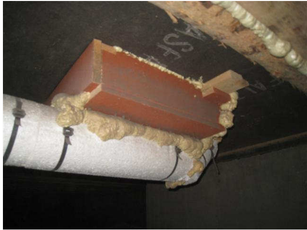
Kuva 16 Lattiakaivon kotelo, saumojen polyuretaanitivistystä.
