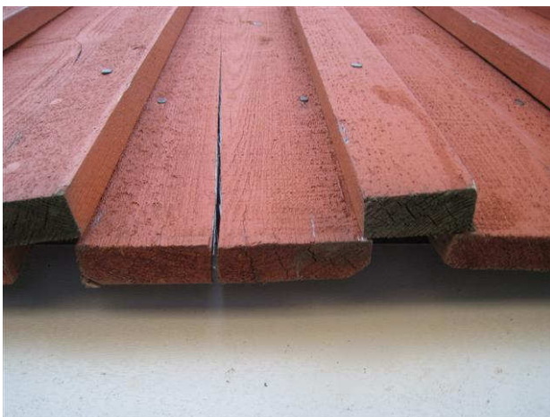
Kuva 17 Ulkuvuorauksen tausta tuulettuu saumarimojen alta pohjalautojen välistä.
