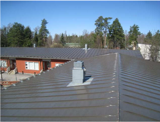
Kuva 27 Yleiskuva vesikatolta, kulkusiltaja ei ole, etualalla alustatilan puhallin.
