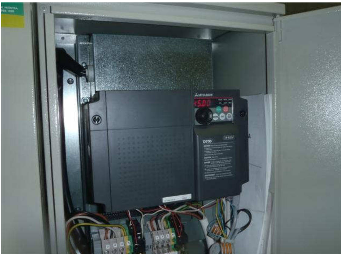
Kuva 4. Poistokoneen taajuusmuuttaja. Molempiin taajuusmuuttajiin on asetettu maksimitaajuudeksi 45 Hz.
