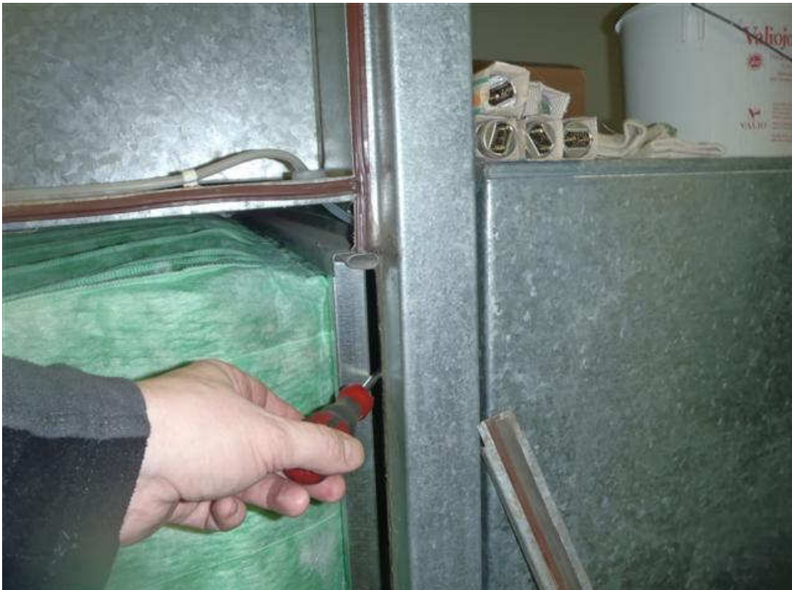
Kuva 2. Poistosuodattimet eivät ole tiiwiisti kiinni suodatinkehysssä.
