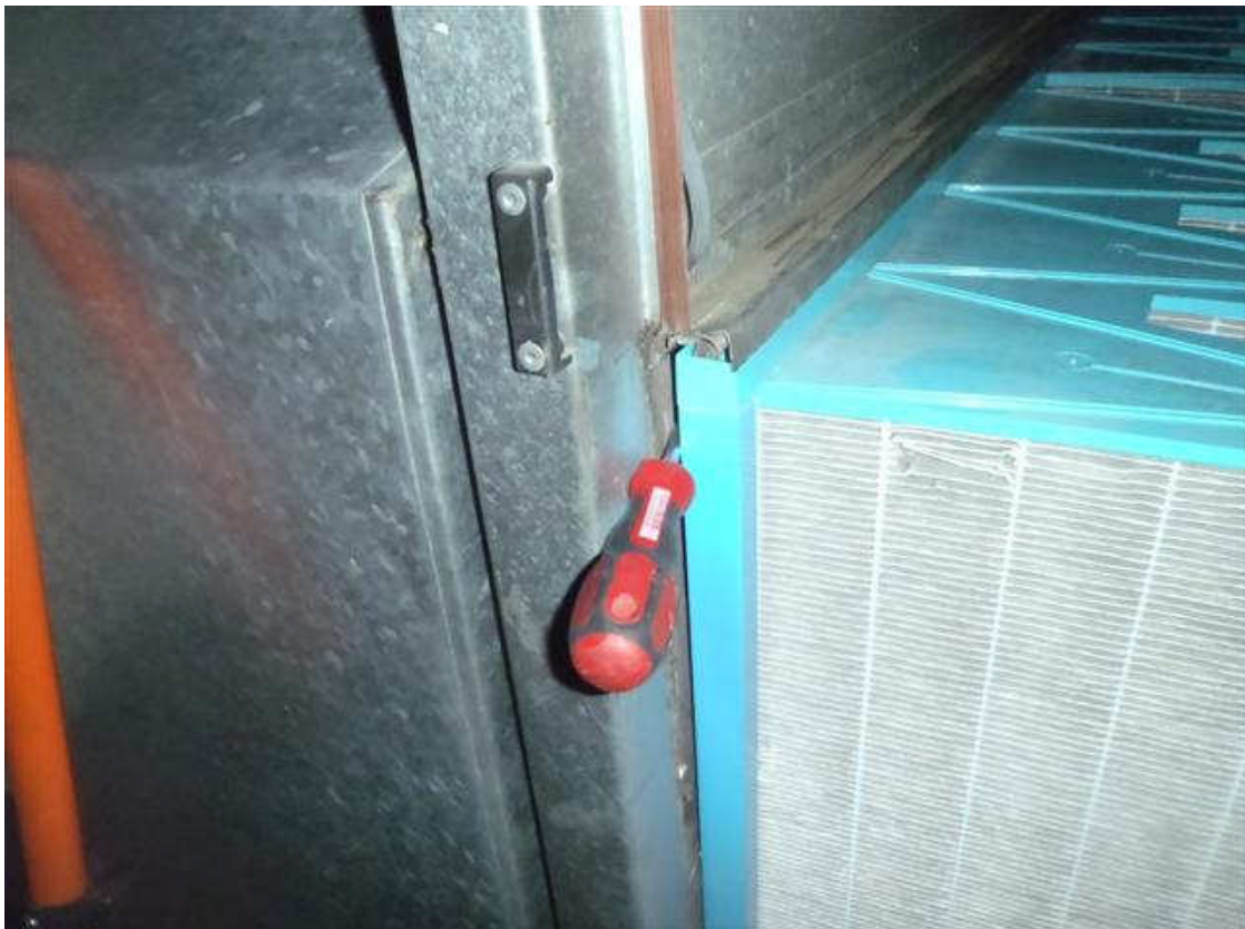
Kuva 3. Tulosuodattimet eivät ole tiiviisti kiinni suodatinkehyksessä.
