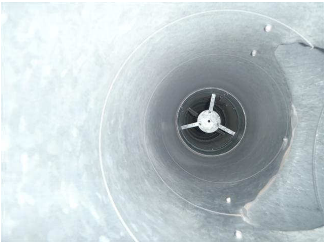
Kuva 6. Puhdas poistoilmakanava.
