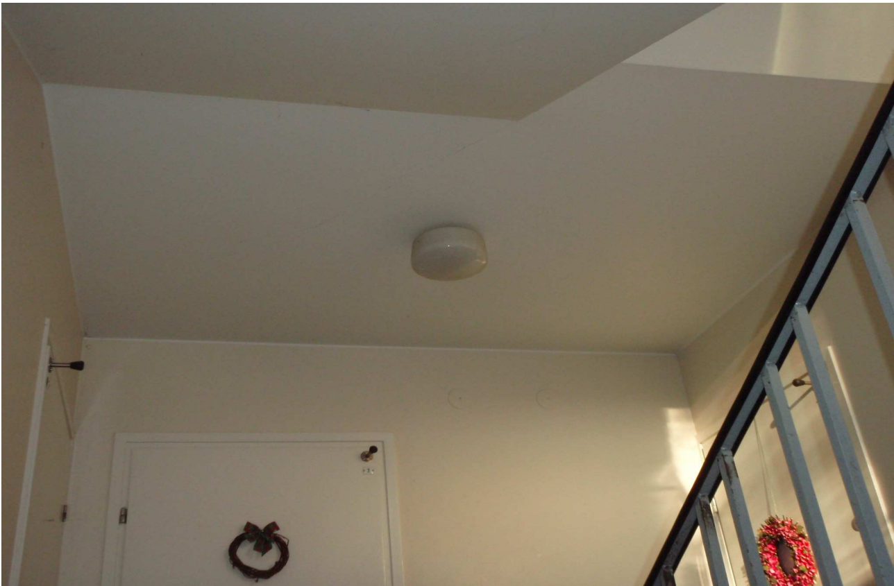
S-kuva 7. Porrashuoneen valaistus.
