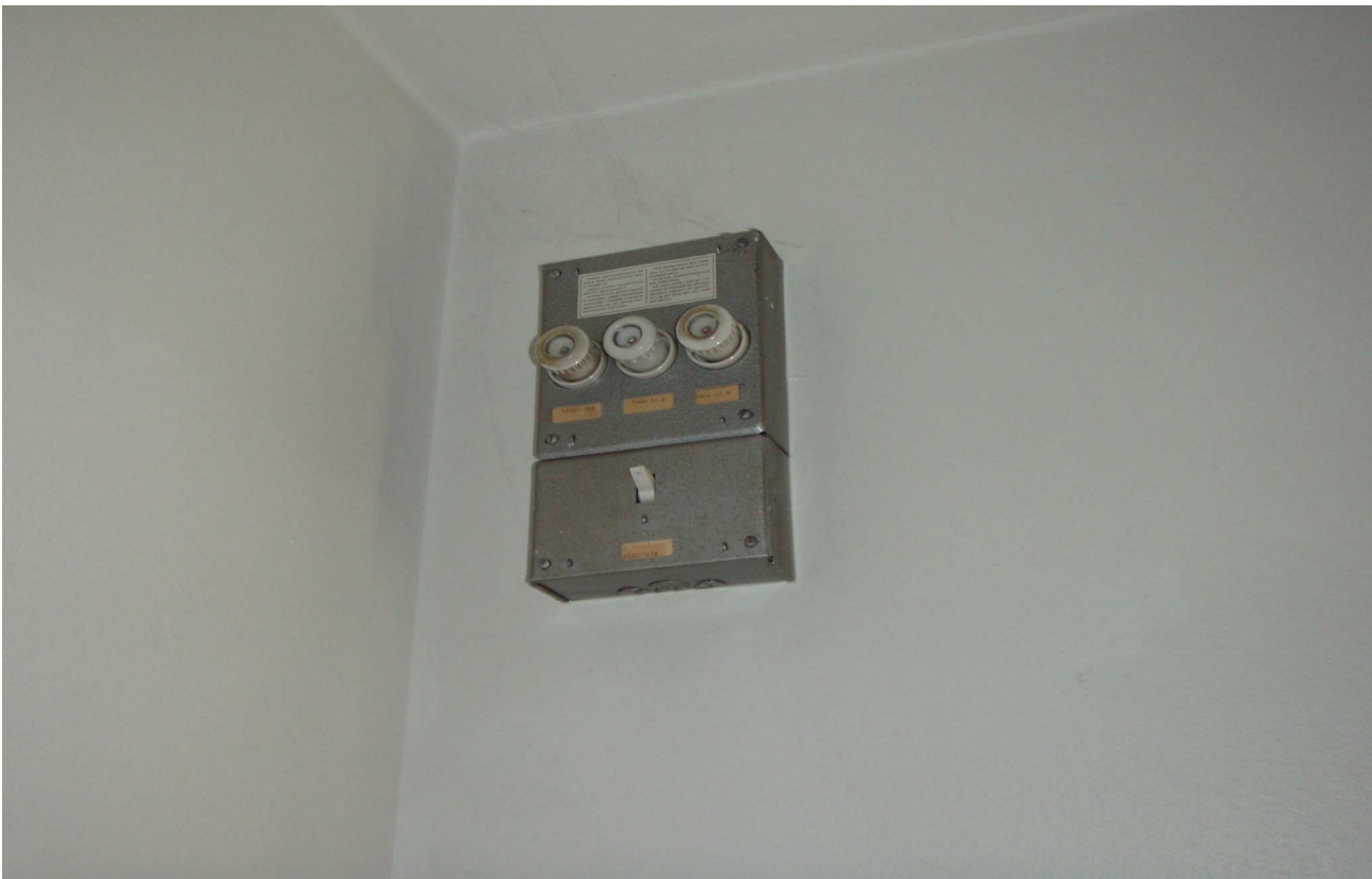
S-kuva 4. Huoneiston keskus.
