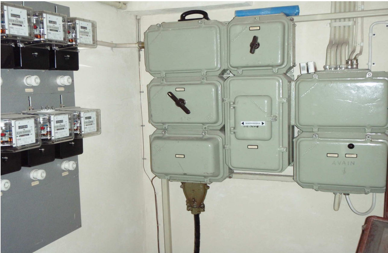
S-kuva 3. Sähköpääkeskus.
