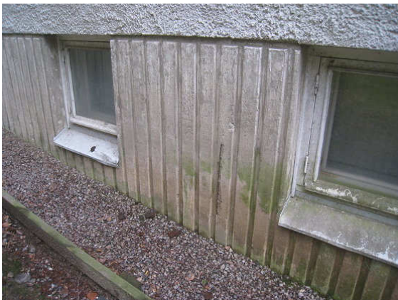
Kuva 7 Ruostunutta raudoitusta näkyvillä.
