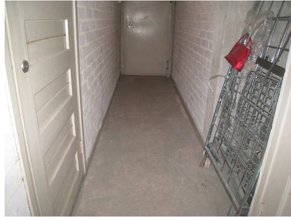
Kuva 4 Maanvaraisen lattian pintakosteus koholla, samoin seinien alaosien.
