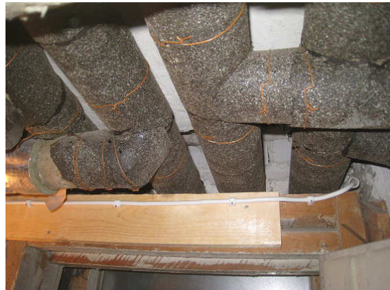
Kuva 12 Tiivistämättömät putkiläpiviennit.
