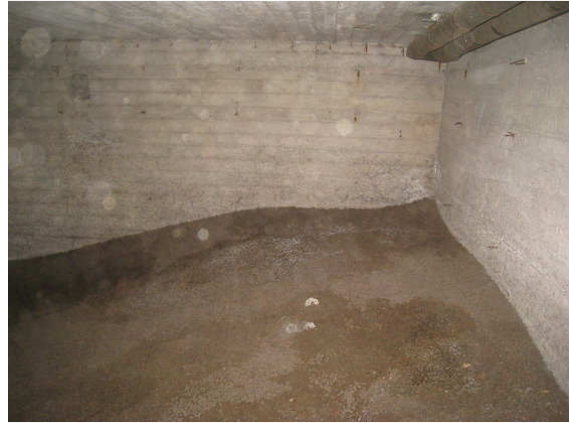
Kuva 10 Leca-soran pinta kostea alustatilassa 1. Pinnassa vaaleaa kasvustoa.
