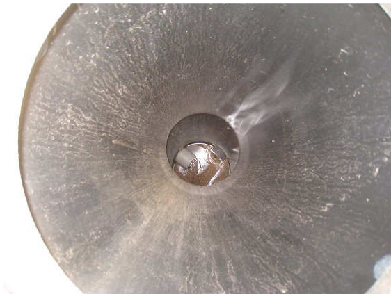
Kuva 8 Koilliskulman salaojien tarkstuskaivo.
