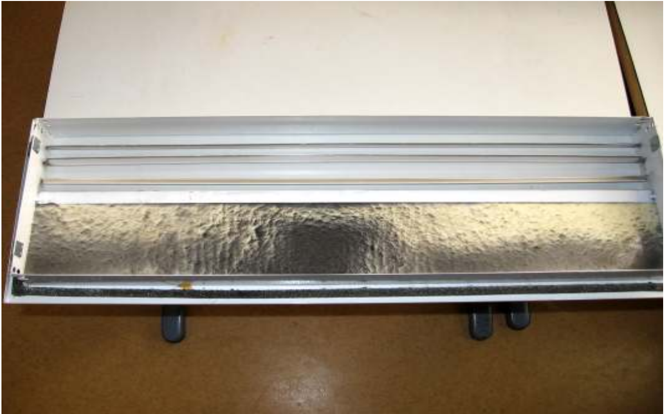
KUVA 11. Tuloilman tasauslaatikoissa ja säleikössä on villapintaeristettä.
