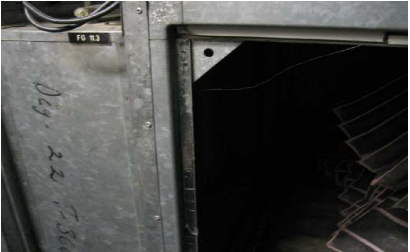
KUVA 1. Yleiskuva luukkujen tiivisteistä.
