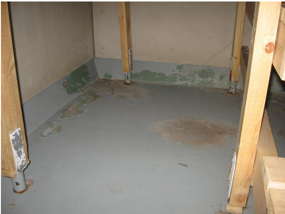
Kuva 6. Yleisnäkö saunan lattiasta.
