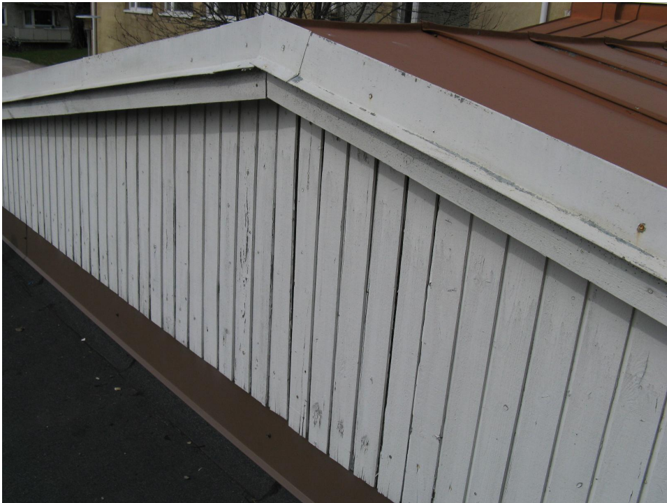
Kuva 34. Huonosti tuulettuva päätykolmio.
