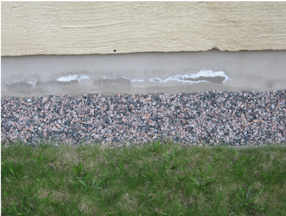
Kuva 21. Kosteusjälkiä perusmuurissa.
