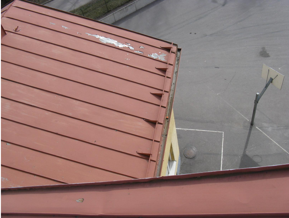
Kuva 31. Osassa kateista pinnoite irtoilee.
