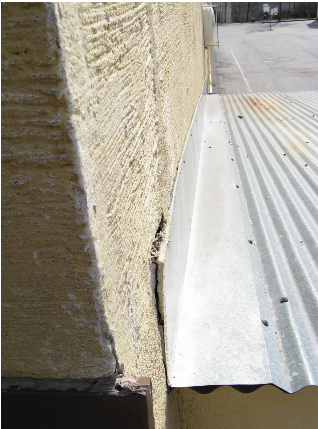
Kuva 36. Avonainen seinälenosto.
