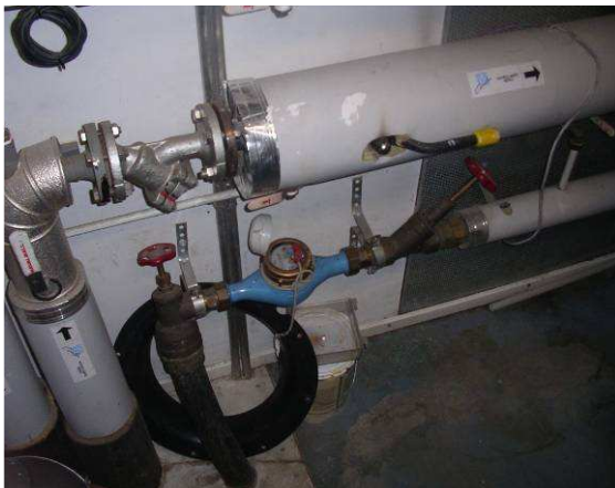
Kiinteistön vesimittari.
