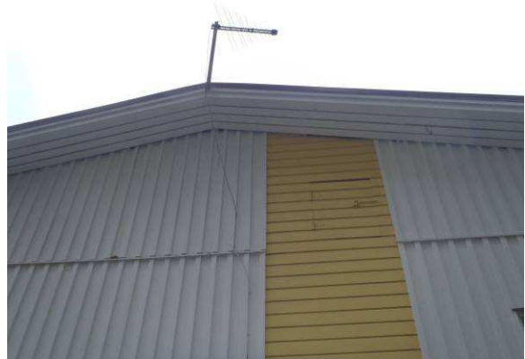
Harava-antennin kiinnitys on huono.
