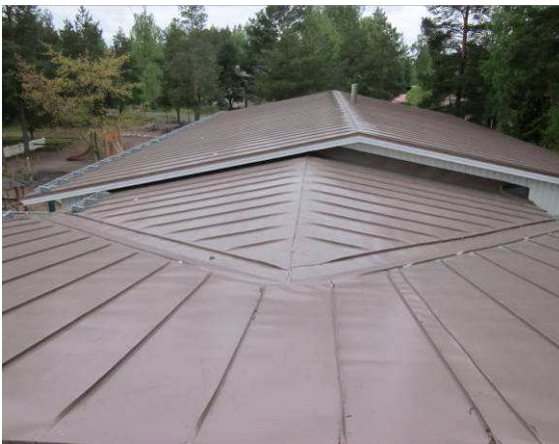
Yleiskuvaa vesikatolta, katemateriaali on konesaumattu peltikate
