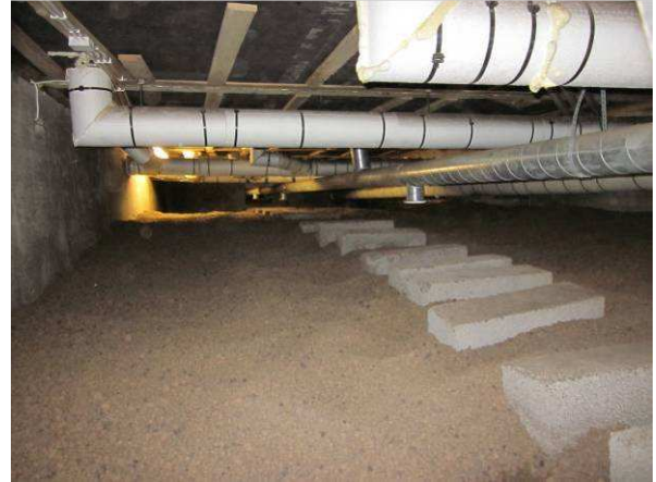
Alapohjatila on peruskorjattu, kevytsoraharkkoja on asennettu kulkuteiksi
