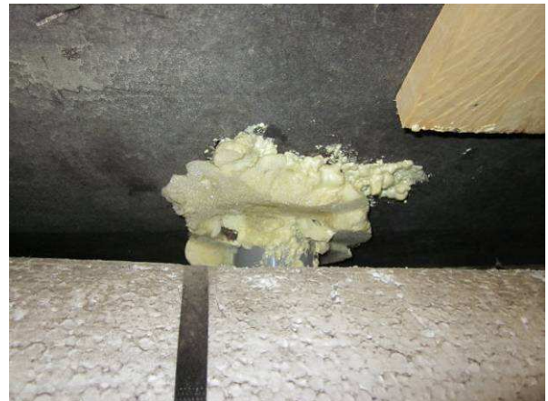
Läpiviennit on tiivistetty polyuretaanilla
