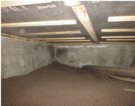
Alapohjatilassa ei havaittu poikkeavaa kosteutta eikä hajua
