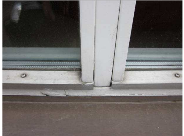
Ikkunoiden maalipinnat ovat vielä kohtuullisessa kunnossa
