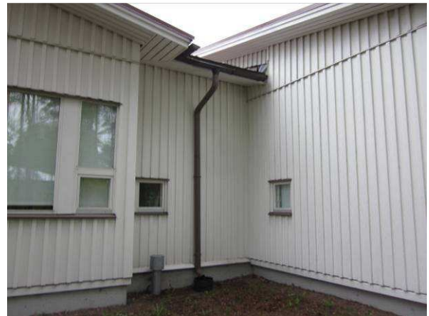
Julkisivujen maalipinnat ovat tyydyttävässä kunnossa
