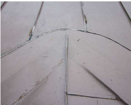
Jiirin saumoja on tiivistetty kittaamalla
