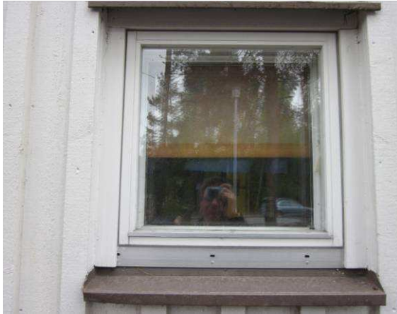
Rakennuksen ikkunat ovat alkuperäisiä puuikkunoita
