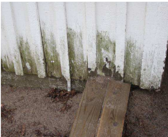
Piharakennuksen ulkoverhous turhan lähellä maanpintaa, -> tihentynyt kunnostustarve
