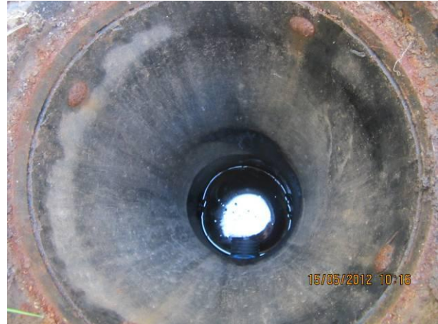
Kuva 4 So-kaivon juoksupinnsta sokkeliin 150 cm varasto 33 kohdalla.
