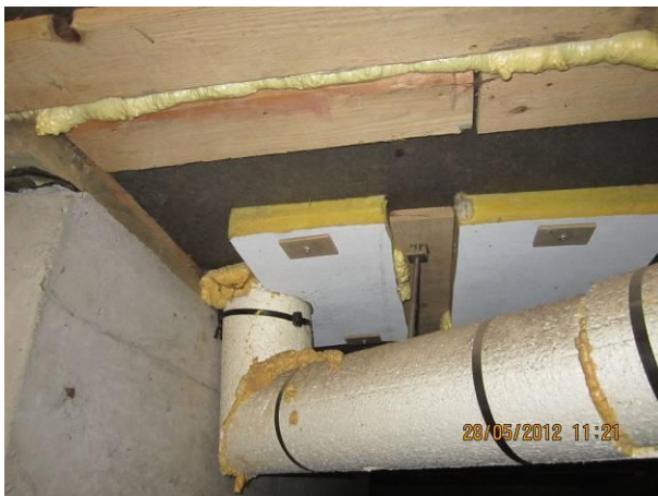
Kuva 19 Tiivistetyt liittymät ja läpiviennit
