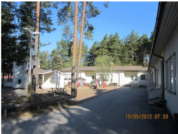
Kuva 9 Asfalttien kallistukset ovat riittävät, sokkelivierillä ei ole asf.makkaroitu.
