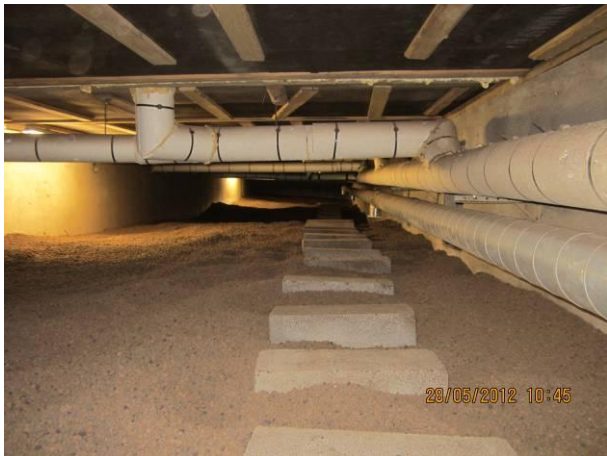
Kuva 13 Keskialueen alustatila, kulkutienä kevytsoran päälle ladotut ks-harkot.
