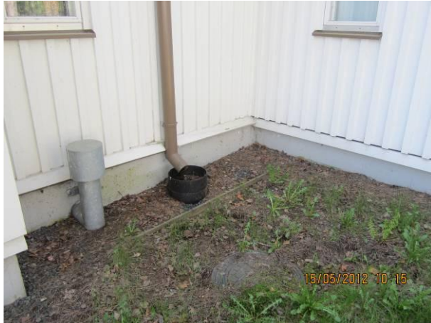
Kuva 3 So-kaivo varasto 33 kohdalla.
