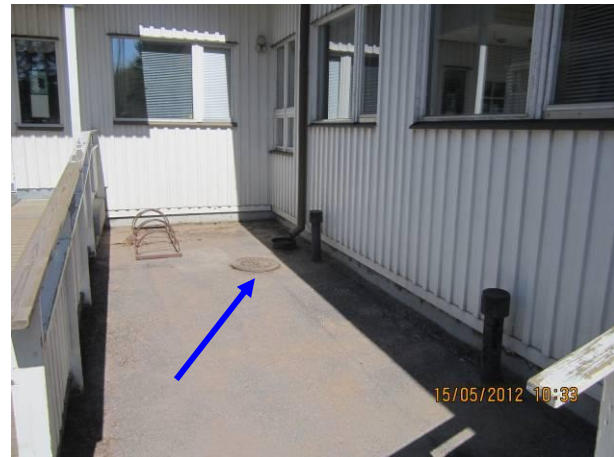
Kuva 6 So-kaivo sisäpihan nurkassa tsto 27 kohdalla, sokkelista juoksupintaan n. 170 cm.
