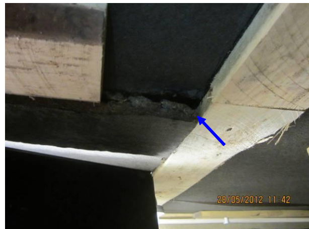
Kuva 20 Bituliittilevy roikkuu saumasta ET 16 alla.
