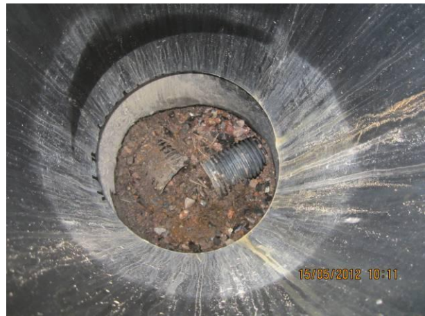
Kuva 2 Tekn. tilan 56 so-kaivon pohjalla soraa, etäisyys sokkeliin 120 cm.
