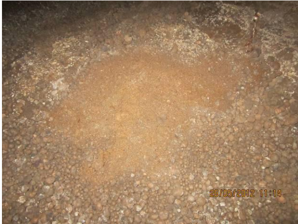
Kuva 17 Mikrobikasvua lkh 50 kohdalla, jossa on vain 5 cm kevytsorakerros.
