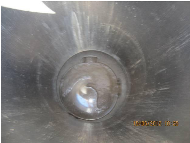
Kuva 5 So-kaivo ryhmäh. 48 kulmalla, lietettä, vesi juoksupinnassa, ei mitattu.
