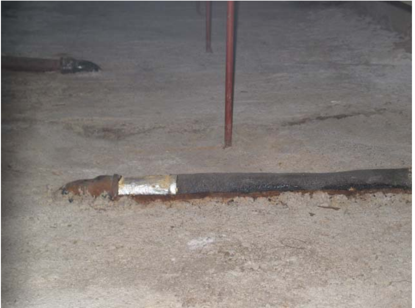
KUVA 7. Jätevesiviemäreitä on korjattu bitumihuovalla putkikanaalissa.
