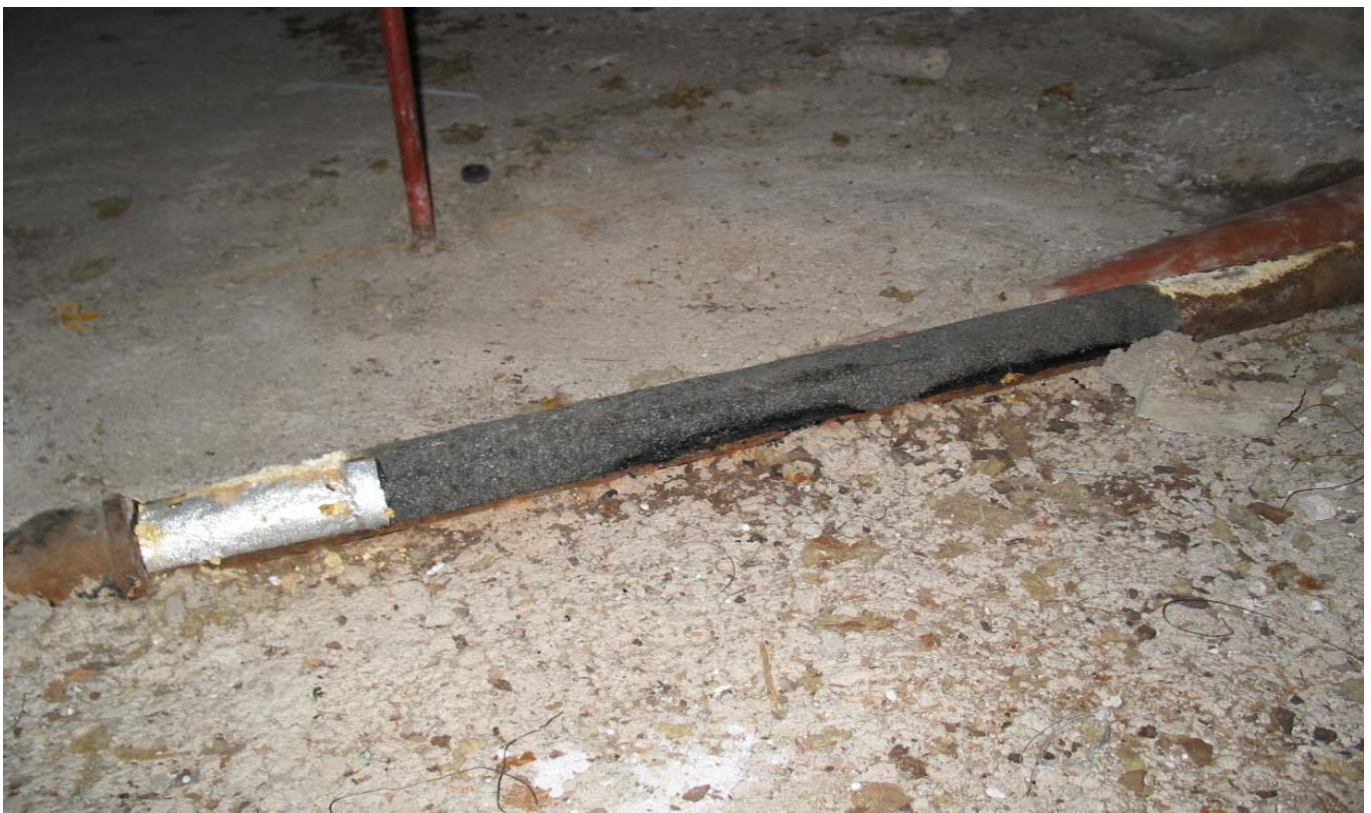
KUVA 6. Jätevesiviemäreitä on korjattu bitumihuovalla putkikanaalissa.
