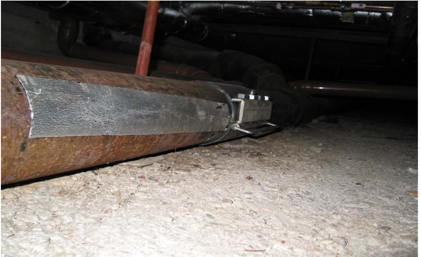
KUVA 7. Jätevesiviemäriä on korjattu bitumihuovalla ja kiristyspannalla putkikanaalissa.
