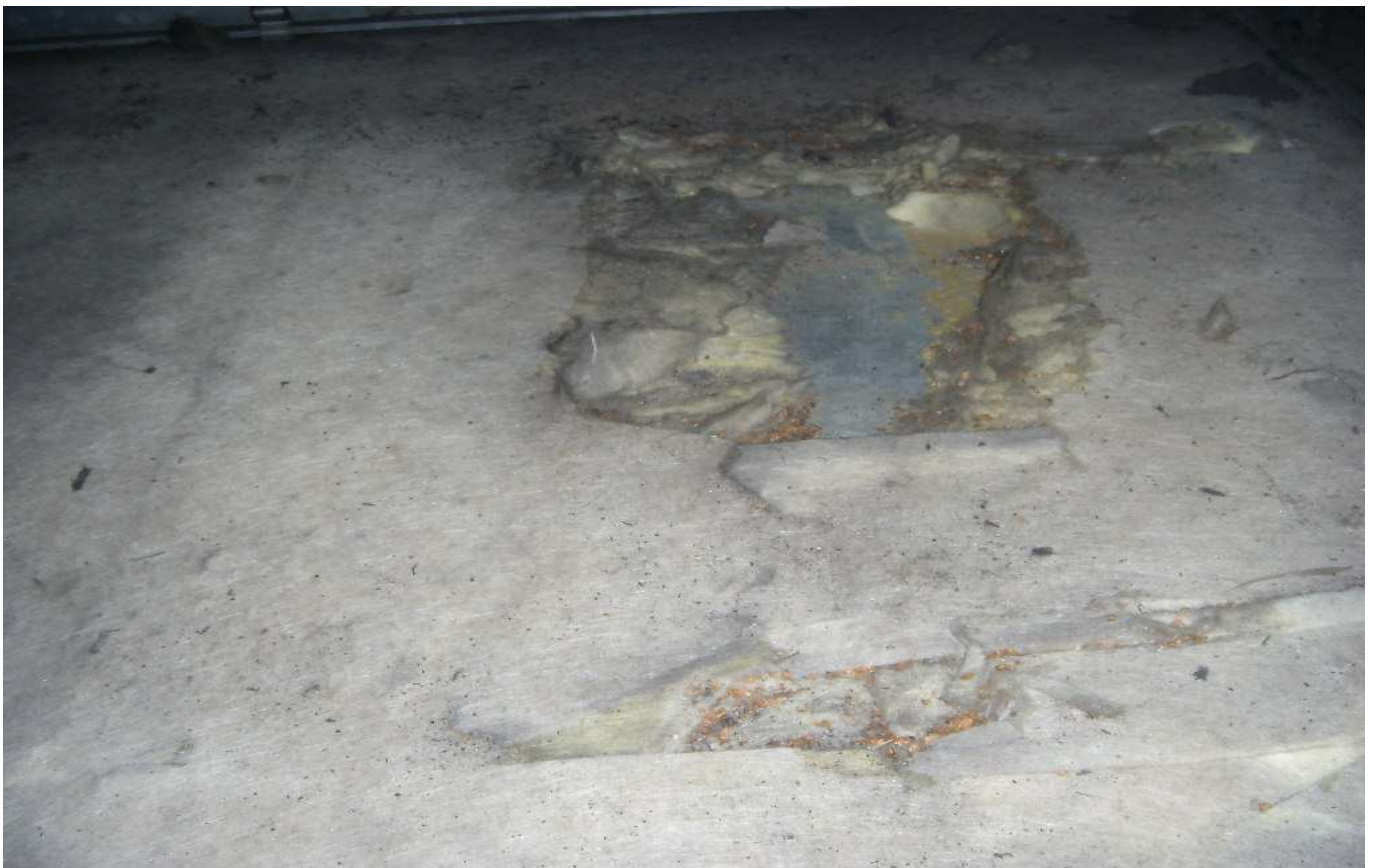
KUVA 9. Yleiskuva tuloilmakoneen kammiosta.
