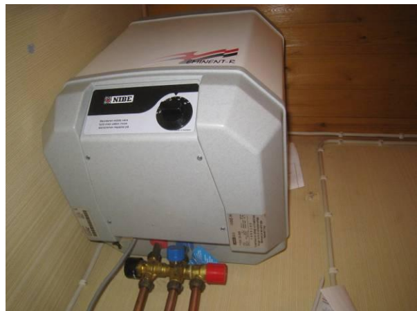
Kuva 44 Uusittu lämminvesivaraaja.
