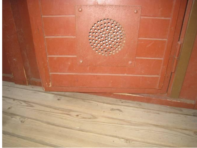
Kuva 8 Ulko-ovi ja venttiili ulkopuolelta.
