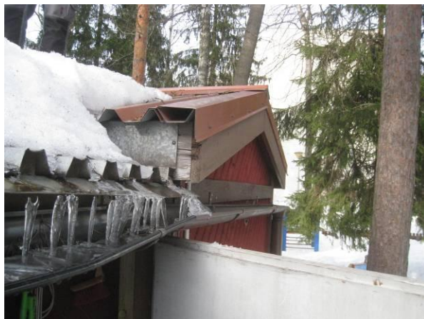
Kuva 41 Huonoja räystäsratkaisuja.
