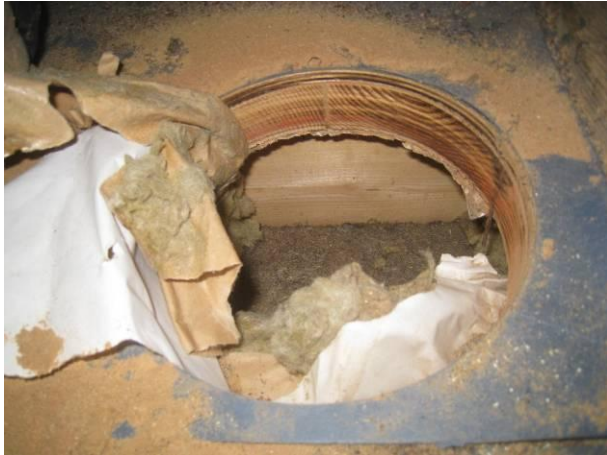
Kuva 25 Rakenneavaus AV5 lattiaan.
