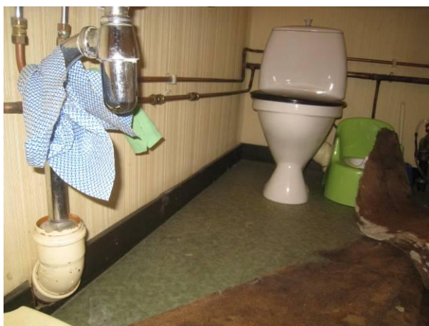
Kuva 47 Alkuperäisiä putkiasennuksia ja vanha wc-istuin.
