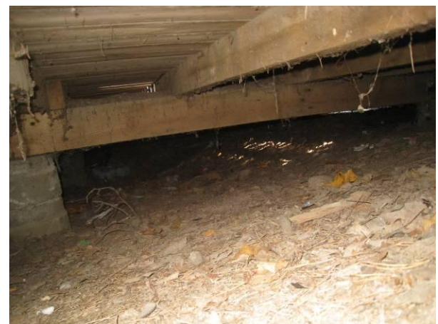
Kuva 36 Terassin lattian alusrakenteita.
