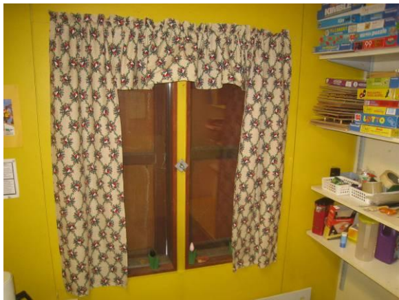
Kuva 5 Ohjaaja-tilan ikkuna ja suojaluukku, joka suljetaan siipimutterilla.
