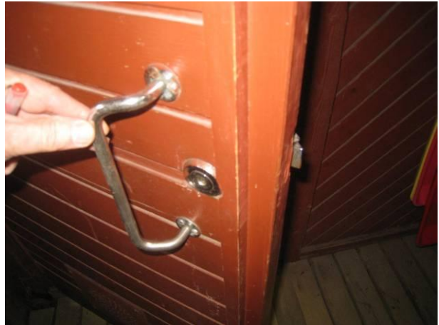
Kuva 28 Kahva oli lähes poikki.
