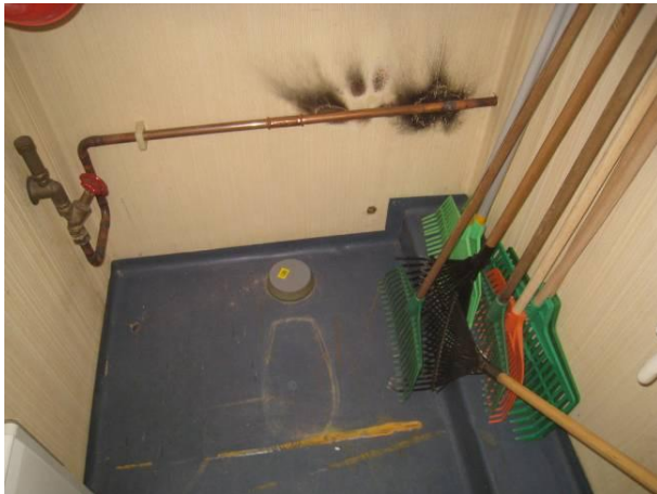
Kuva 45 Toinen wc-tila on muutettu siivoustilaksi, putkia on korjattu.
