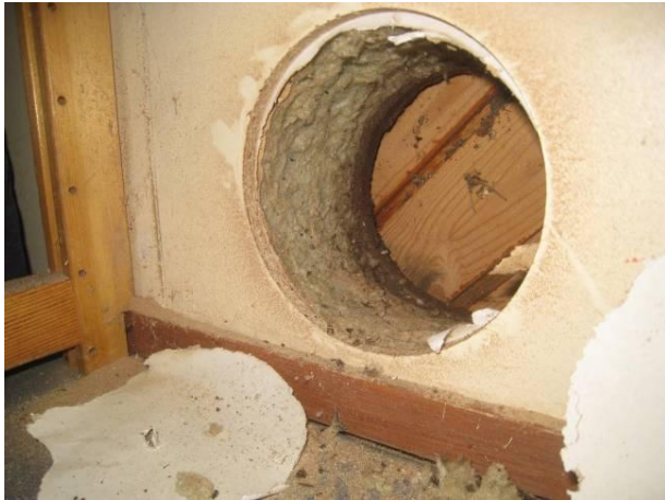
Kuva 31 Rakenneavaus AV6 itäpäädyn seinään.
