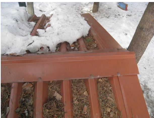
Kuva 11 Vesikate on uusittu.
