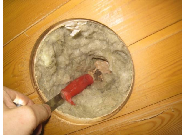
Kuva 32 Rakenneavaus AV7 yläpohjaan.
