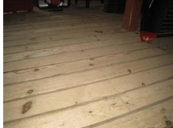
Kuva 40 Kulunut terassilauδοitus.
