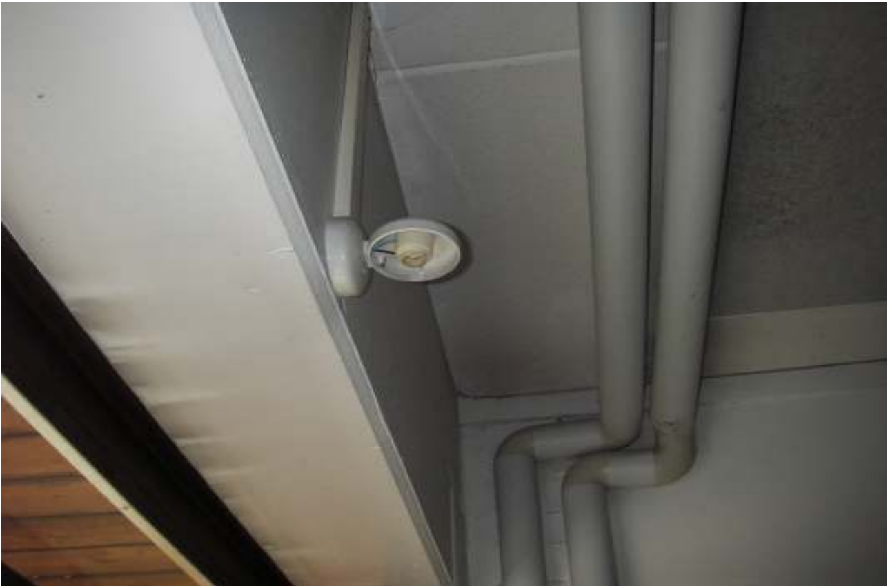
S-KUVA 1. Rikkinäinen ovimerkkivalaisin.
