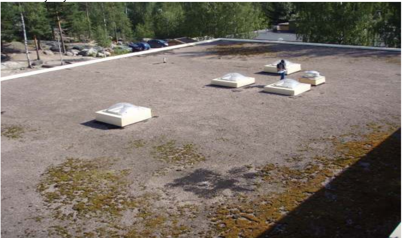
R-KUVA 4: Tasakattorakenne on teknisen käyttöiän lopussa ja rakenteen kunnostus tulisi suorittaa lähivuosien aikana.
