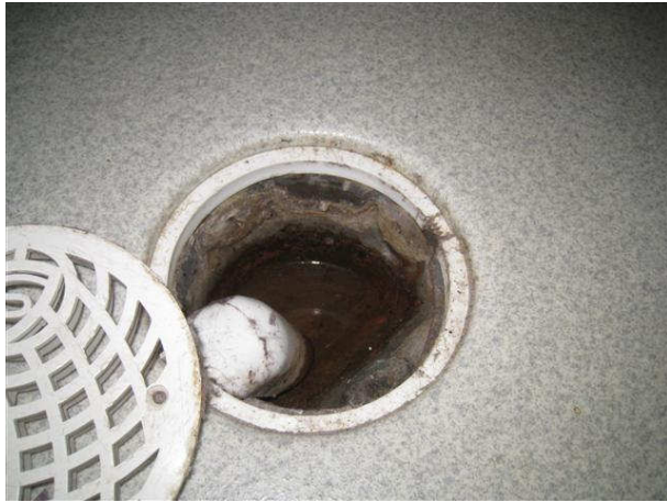
Kuva 37 Märkätilojen lattiakaivot ovat valurautaa.
