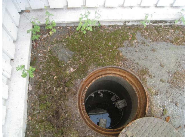
Kuva 14 Tarkastettu salaojakaivo huoltopihalla, asfaltin pinta on lähellä lattiatasoa.
