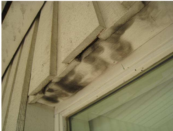
Kuva 21 Savujälkiä sytyttimen tv. jäljiltä.
