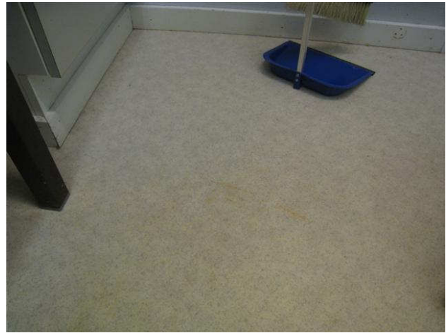
Kuva 50 Värjäytynyt lattiamatto.
