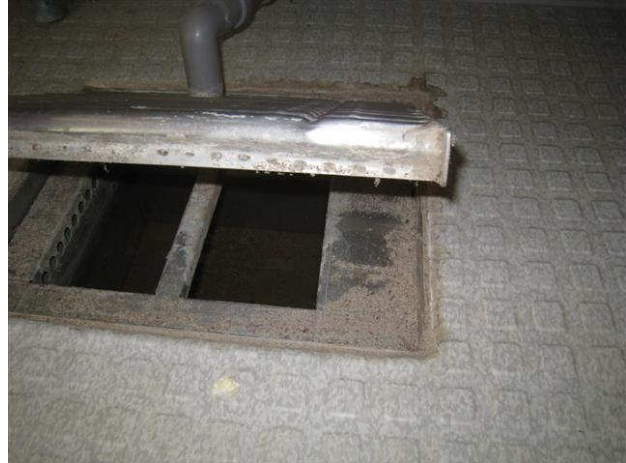
Kuva 32 Märkäeteisen lattiakaivo ja nasturapintainen muovimatto.
