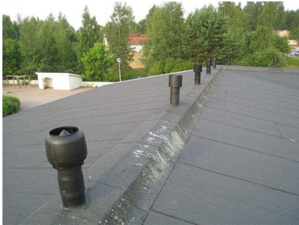
Kuva 27 Harjalla oleva tuuletuskanava ja alipaineventtiilit.
