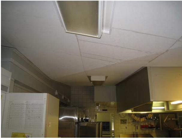
Kuva 39 Keittiön kattoa on korjattu vuotojen takia, nyt on akustiikkalevyt katossa.
