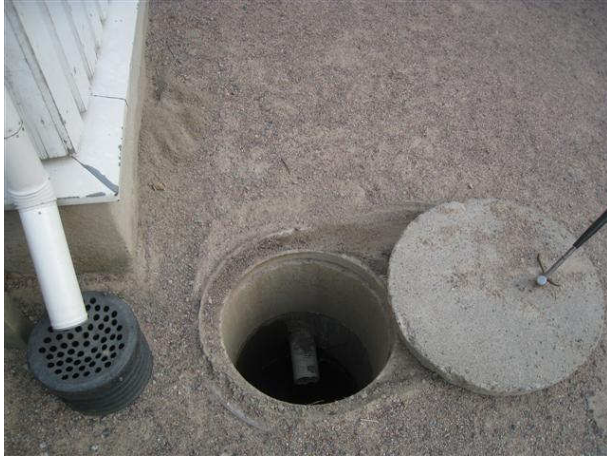
Kuva 13 Tarkastettu salaojan tarkastuskaivo koillispäädystä.
