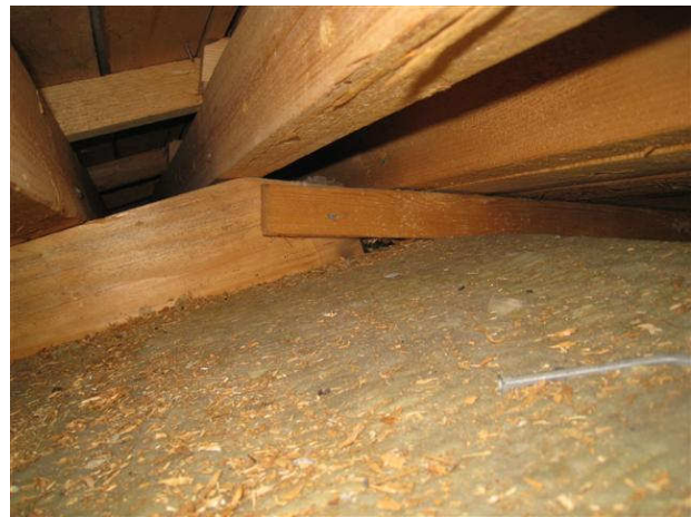
Kuva 28 Tuuletuskanavan kohdalla rakenteet vaikuttivat terveiltä ja tuuletus toimii
