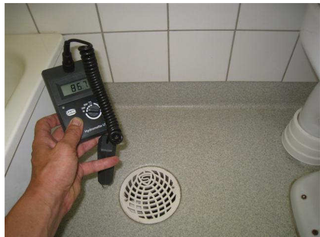
Kuva 36 Lasten wc-tilan lattian pintakosteusarvot vastasivat likimain kuivaa rakennetta. Liittymä vaikutti tiiviiltä.
