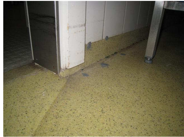
Kuva 40 Keittiön ovikynnys käytävälle on am. luiskakynnys. Lattiassa ja seinässä on tod.näk. porareikiä mitausten jäljiltä.
