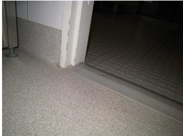
Kuva 34 Märkätilojen ja kuivien tilojen väliset kynnykset ovat muovilistaa. Matoissa on am. juurinotot.
