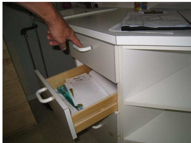
Kuva 48 Alkuperäinen laatikosto, kahvat ovat huonosti kiinni.
