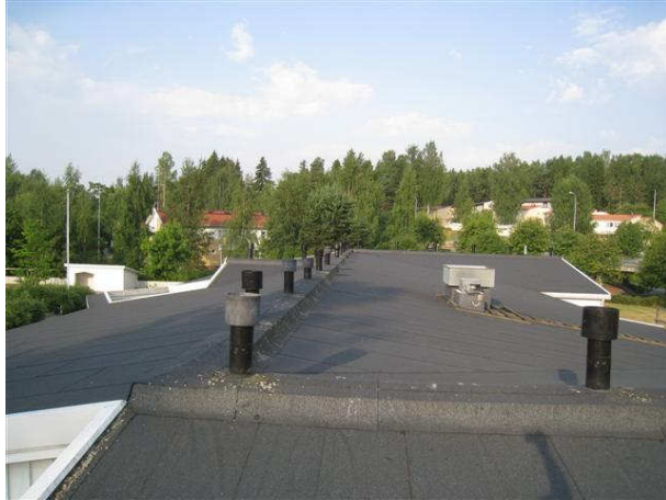
Kuva 25 Yleiskuva vesikatolta, paikoin on jäkälää, huopa on kunnossa.
