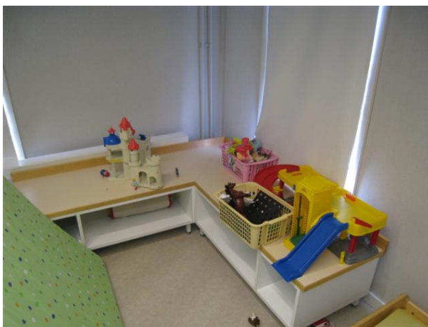
Kuva 53 Tämä nurkkavuode peittää patterin ja termostaatin, mikä voi aiheuttaa kylmyyttä.
