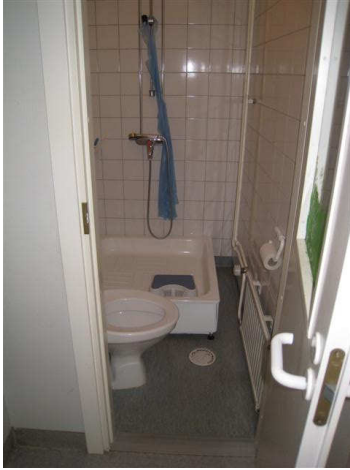
Kuva 43 Käytävällä oleva lasiovellinen wc-tila.
