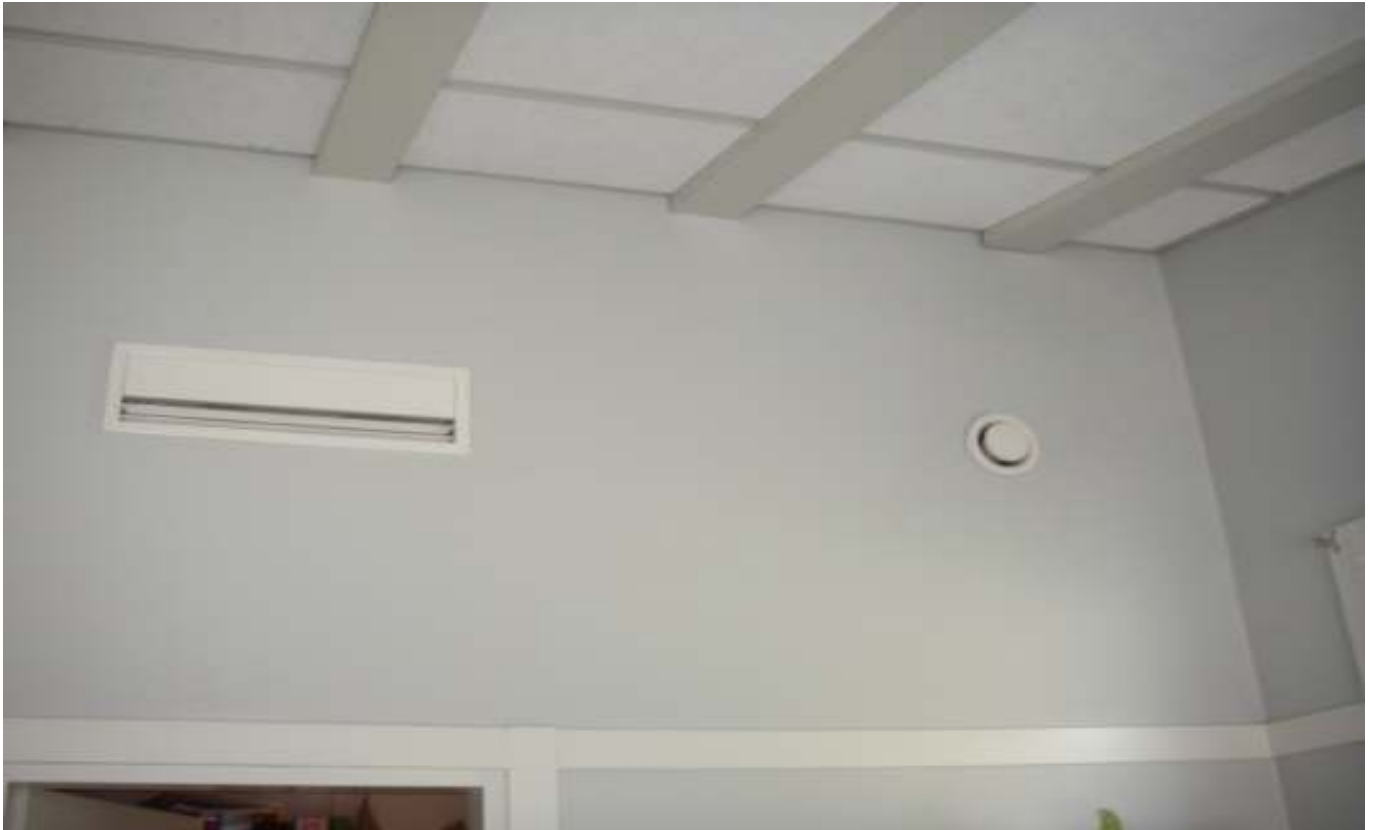
KUVA 17. Yleiskuva huoneiden ns. ritiläsäleiköstä.
