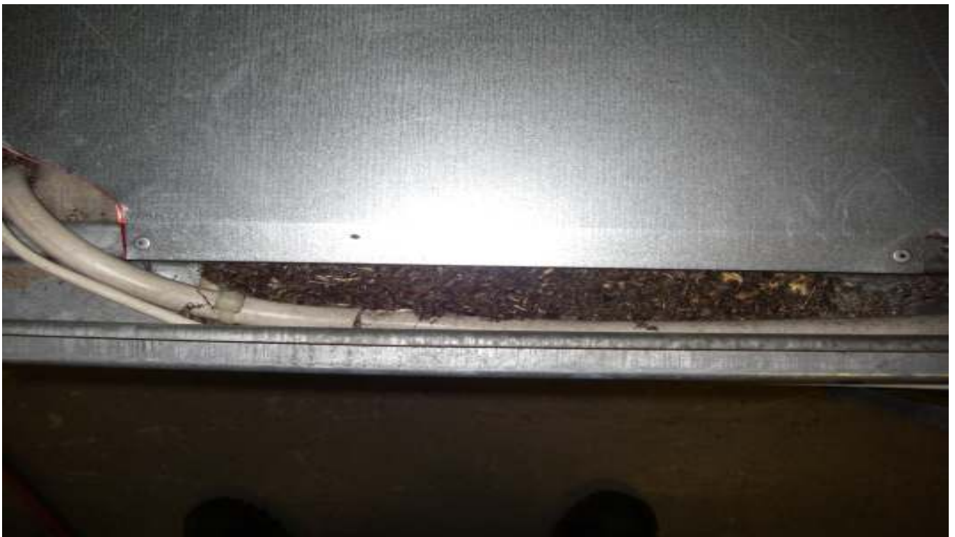
KUVA 6. Tuloilmapuhaltimien kammiossa on melko paljon roskaa.
