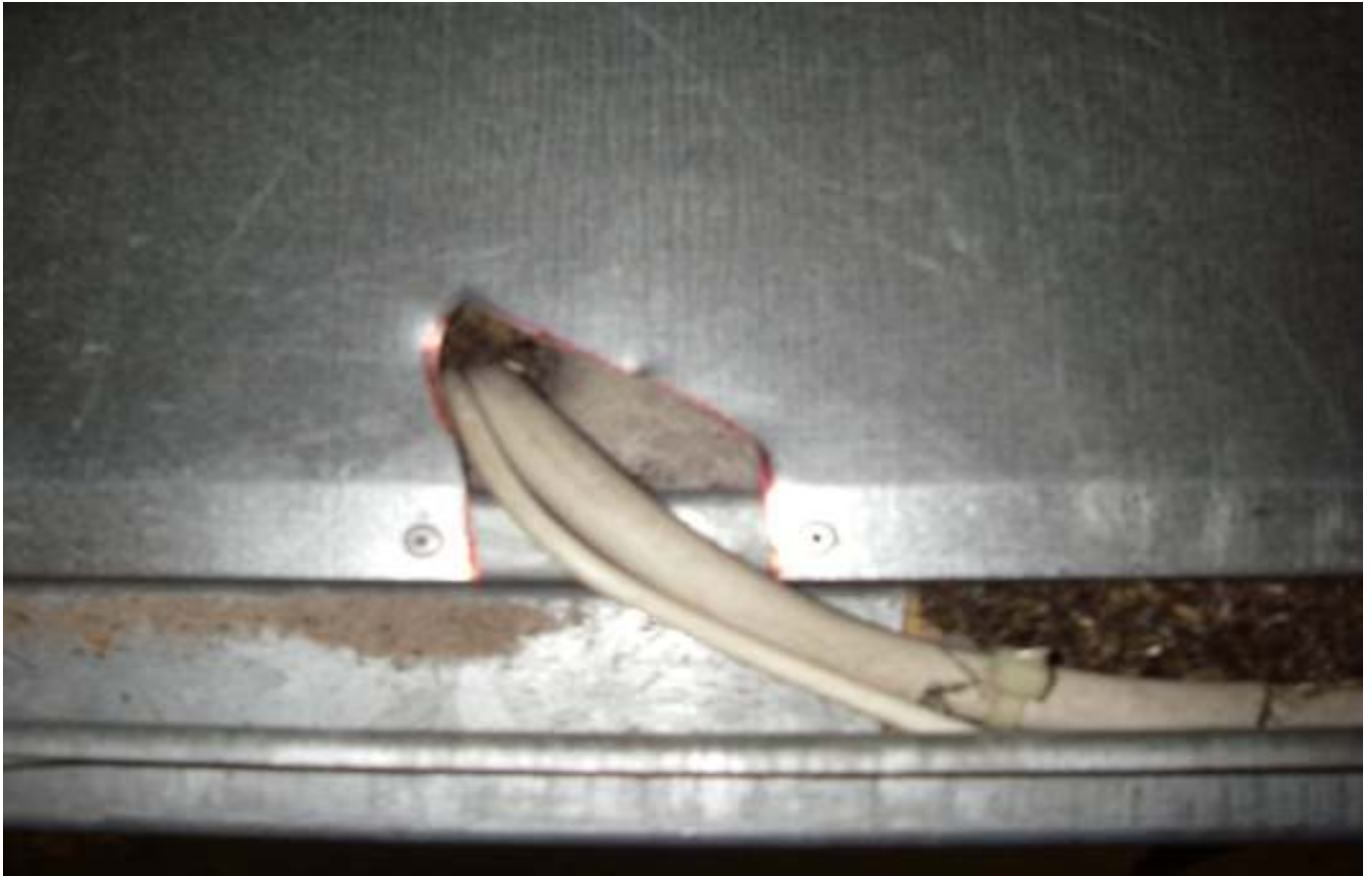
KUVA 7. Yleiskuva koneen läpivienneistä.
