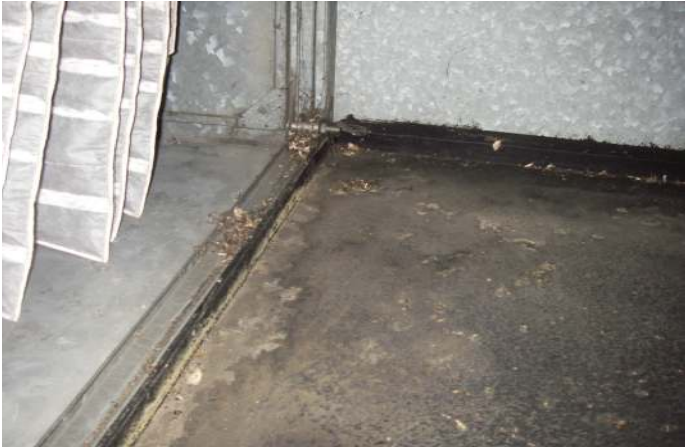
KUVA 5. Tuloilmapuhaltimien kammiossa on melko paljon roskaa.
