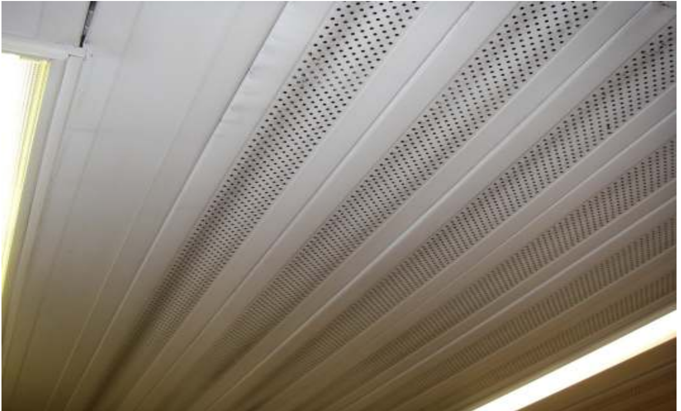
KUVA 23. Yleiskuva keittiön etuosan katosta.
