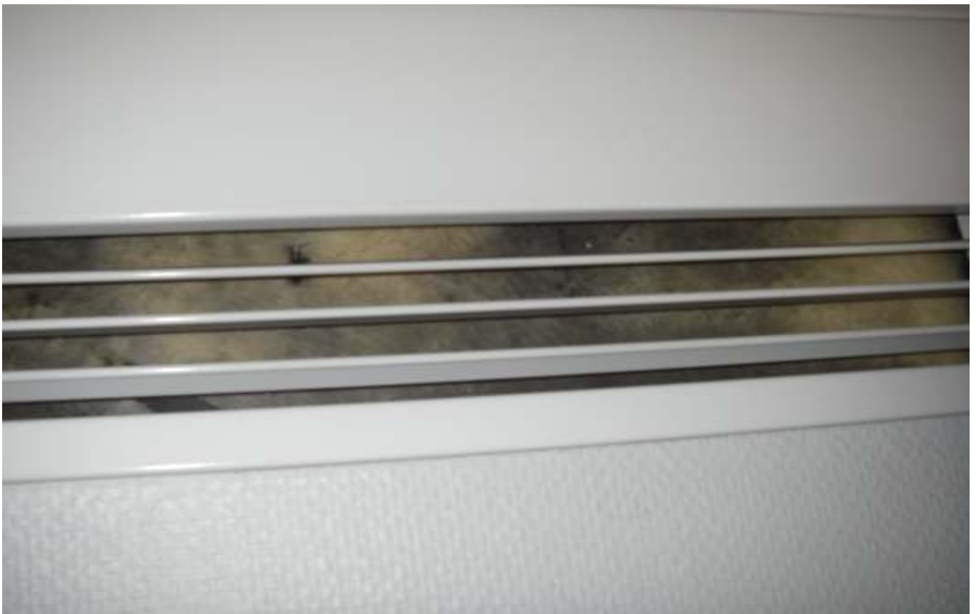
KUVA 18. Tuloilmasäleiköissä on mineraalivillaeristettä.
