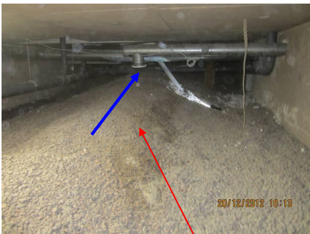
Kuva 5 Alkuperäisen osan poisto kellarin viereisen lohkon kohdalla. Jyrkässä penkereessä on ohuelti sepeliä, havaittiin selvää mikrobihajua.
