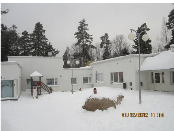
Kuva 3 Sisäpihaa, itäpihalla maasto viettää länteen kohti rakennusta.
