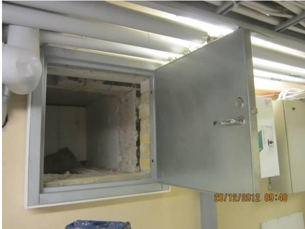
Kuva 39 B-osan kulkuluukun sivuilta on ilmayhteys entiseen ulkoseinään joka on nyt väliseinänä.
