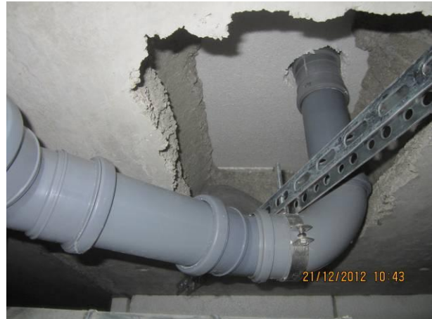
Kuva 36 Tiivistämätön läpivienti
