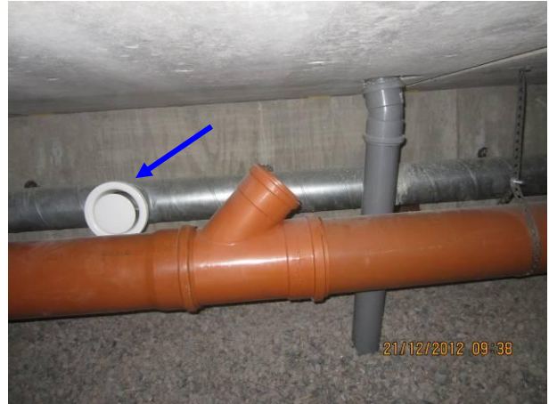
Kuva 14 Laajennuksen 2000 poistokanava on vanhan, käytöstä poistetun poistokanavan vieressä.
