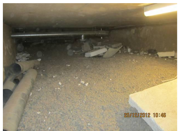
Kuva 8 Purettua kanavaa ja muuta rakennusjätettä, poistoputki ja sen nousu nurkassa keskilohkossa.
