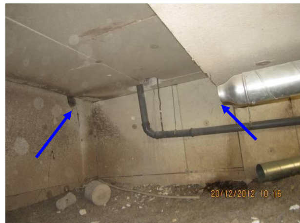
Kuva 6 Ap- osan tulo kellarin viereisen lohkon sivulla, nurkassa on korvausilmareitti sis.käyntitason alle onteloon (ks. 21).
