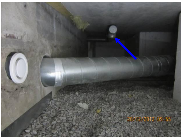
Kuva 11 Laajennuksen v. 2008 B-osan poisto, taustalla tulokanavan pää.
