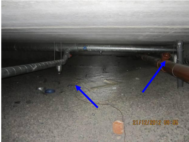
Kuva 13 Laajennuksen v. 2000 tulona on peltikanava, joka on ilmeisesti asennettu v. 2008, vanha poisto oikealla.
