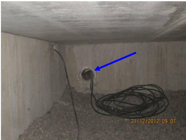
Kuva 13 Laajennuksen v. 2000 tulona on peltikanava, joka on ilmeisesti asennettu v. 2008, vanha poisto oikealla.
