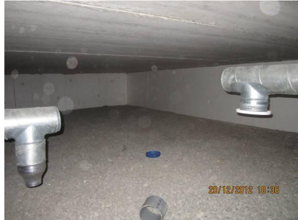
Kuva 10 2008 C-laajennusosan/ salin alla olevan alustatilan tulo-poisto.
