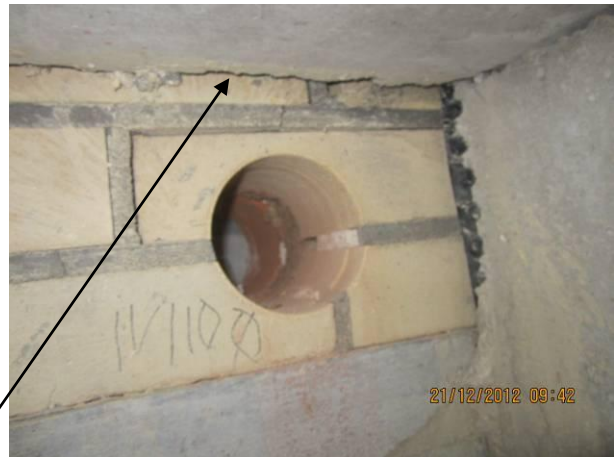
Kuva 32 Entisen ulkoseinän, nykyisen väliseinän IV-läpivienti, jossa rakenne on esillä: js-tiili, villa 50 mm, punatiili, juurinosto.
