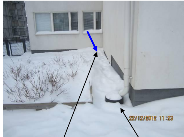
Kuva 2 TK13 tarkastettiin sisänurkassa. Laajennuksen 2008 C-osan rännikaivo.
