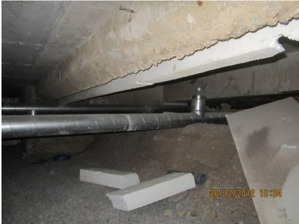
Kuva 9 Tulokanava lepää soran päällä alkuperäisen osan ja C-laajennusosan rajalla, josta on yhteys lohkojen välillä.
