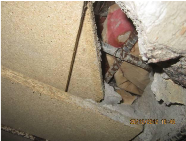
Kuva 23 Vanhaa valumuottia ja mahdoll. ilma- vuotoreittejä.
