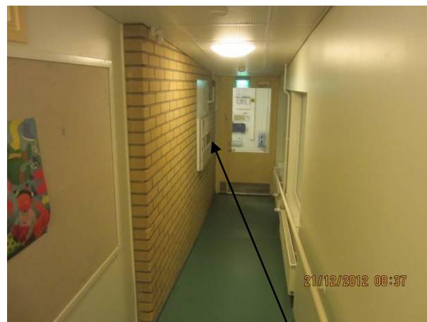
Kuva 33 Entinen ulkoseinä käytävän luiskan sivulla, jossa seinään upotettu pikapaloposti.
