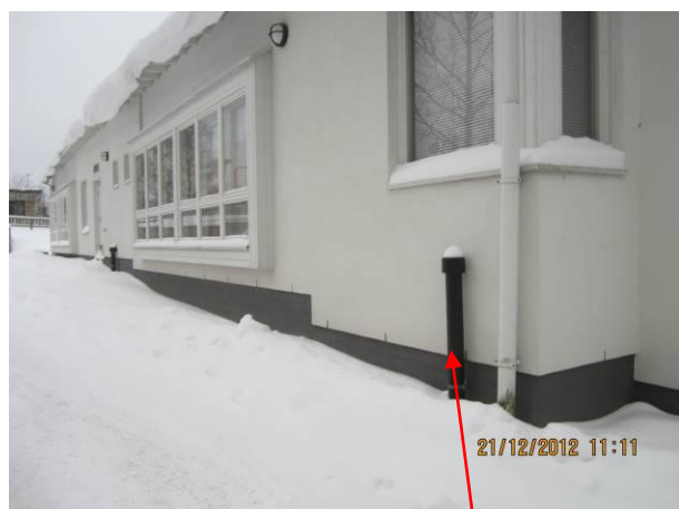
Kuva 4 Pohjoissivulla maasto viettää poispäin rakennuksesta. Laajennusosan v. 2000 alustatilan tuuletusputki.
