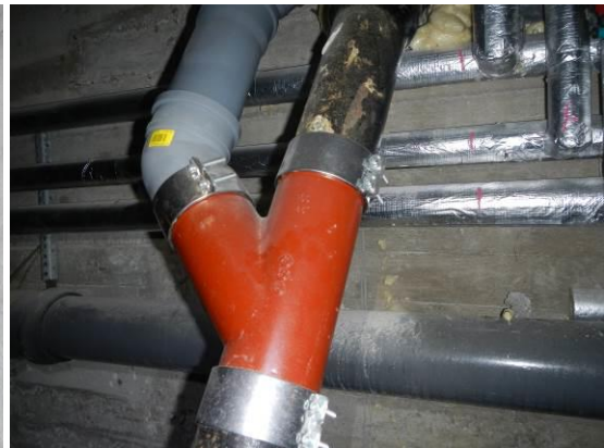
Kuva 16. Jätevesiviemäreitä on paikoin uusittu.
