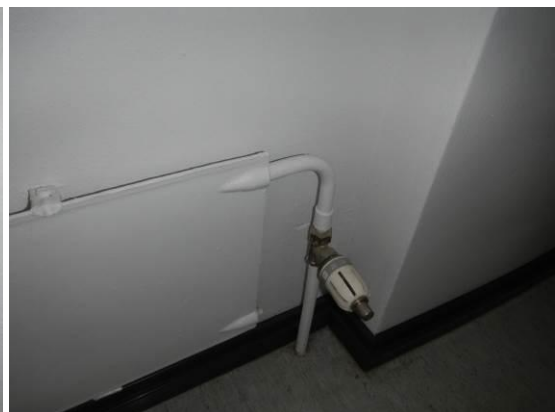
Kuva 6. Vanha patteriventtiili, merkki Oras.
