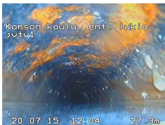
Kuva 23. Vesitäyttöä pohjarunkoviemärissä (takalaskuinen), jvtv1.
