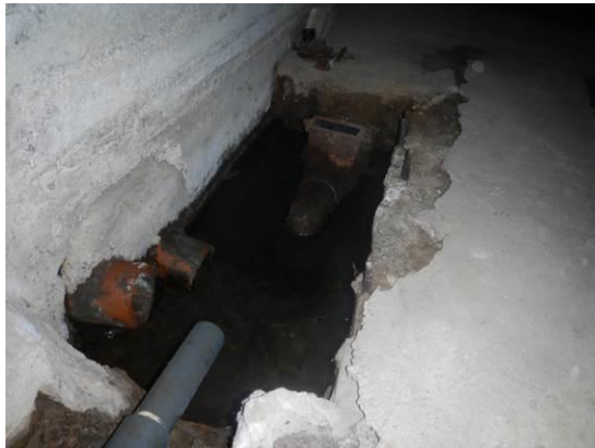
Kuva 25. Perusvesikaivo/betoniallas putki-tunnelissa.
