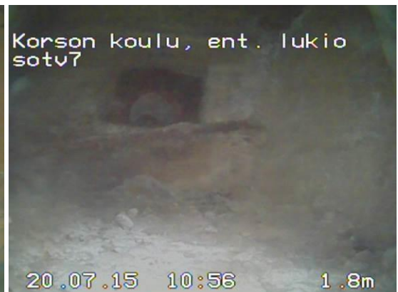
Kuva 30. Kaivo/betoniallas tai alustatila linjojen sotv7 ja sotv8 välissä.
